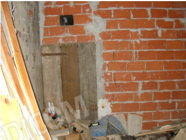
Locale cantina in piano seminterrato (sub.40)
