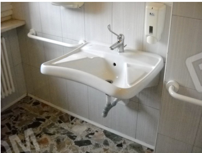
Locale commerciale servizi clienti (sub.34)
