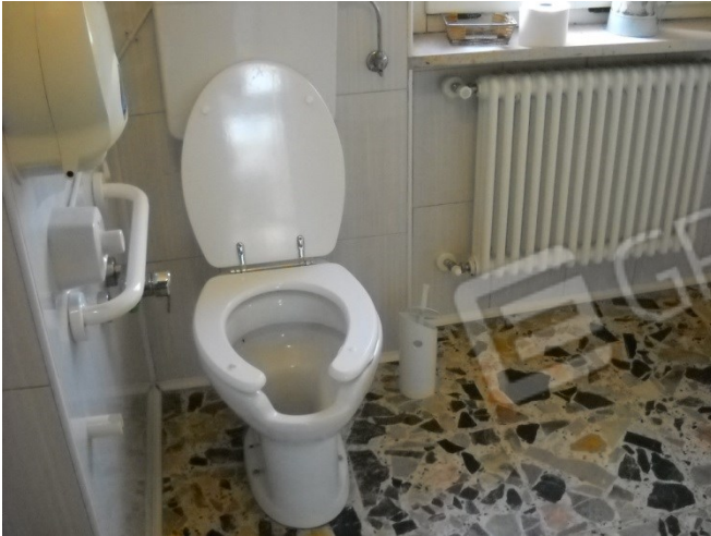
Locale commerciale servizi clienti (sub.34)
