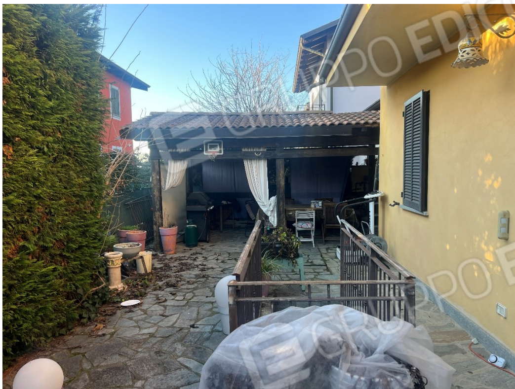
Figura 5 tettoia vista da sud a confine lato Nord
