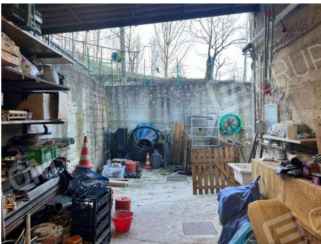
Figura 22 tettoia realizzata sul nm. 991
