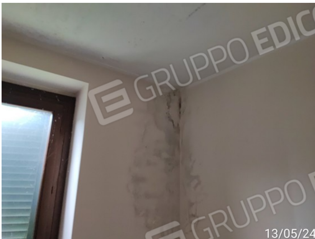
Fotografia E.33 - 34 Particolare infiltrazioni Appartamento
