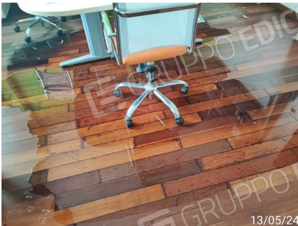
Fotografia E.19 - 20 Pavimento in legno allagato
