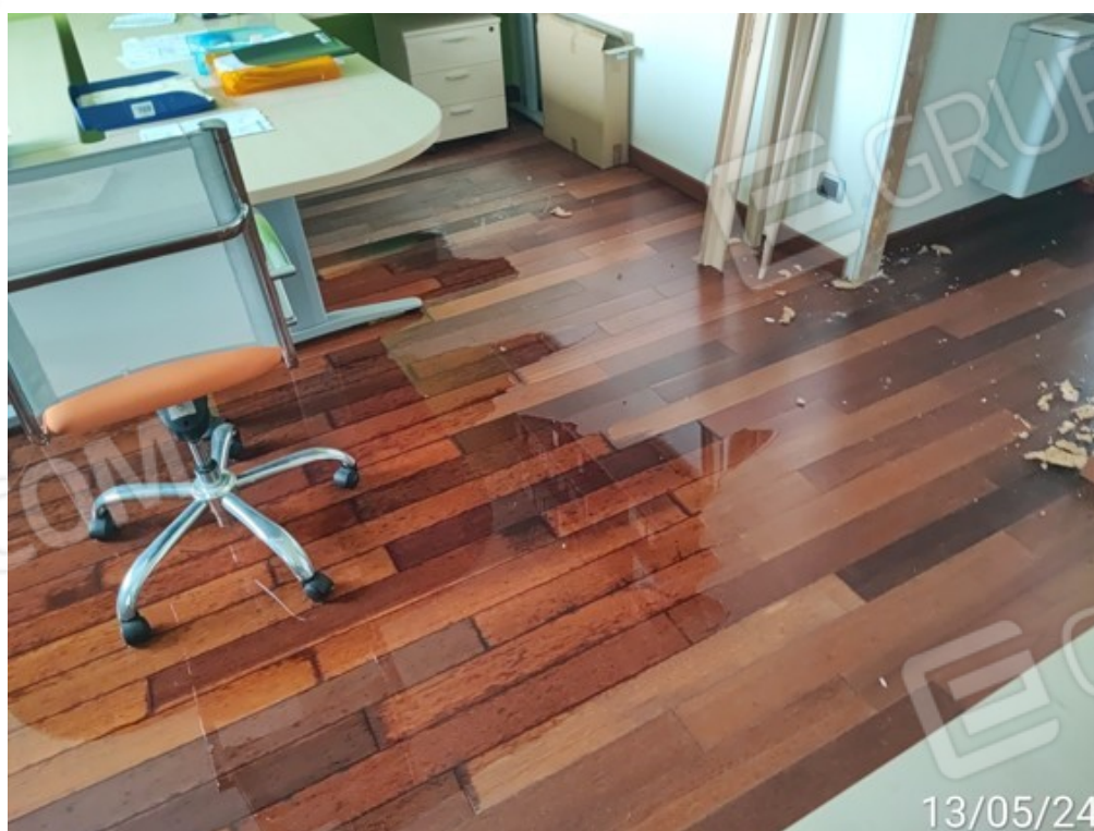
Fotografia E.20 - 21 Pavimento in legno allagato
