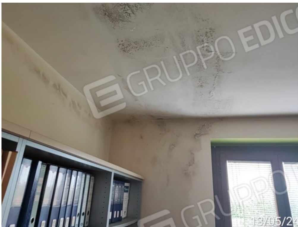
Fotografia E.21 - 22 Particolare tracce di umidità da infiltrazioni
