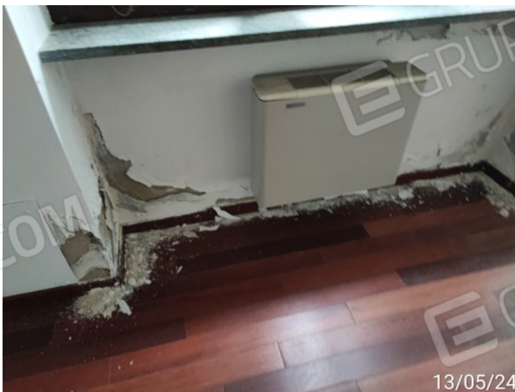
Fotografia E.22 - 23 Particolare tracce notevoli di umidità da infiltrazioni
