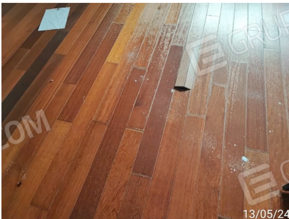
Fotografia E.18 - 19 Particolare pavimento in legno danneggiato
