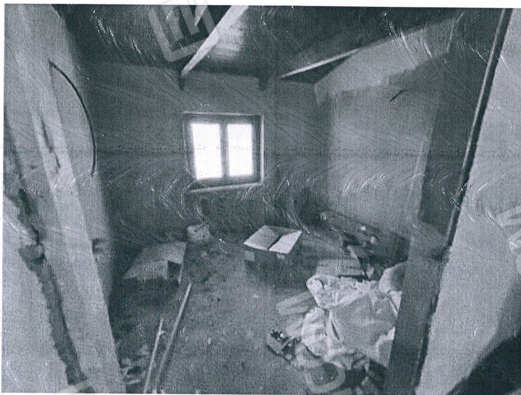
Vista interna locali piano sottotetto – locale sottotetto e bagno ( predisposizione impianti )
