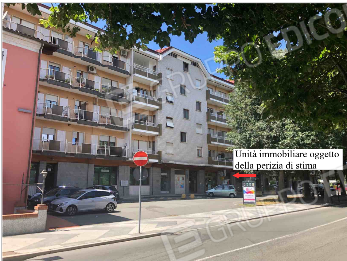
Foto n.1: strada di accesso
