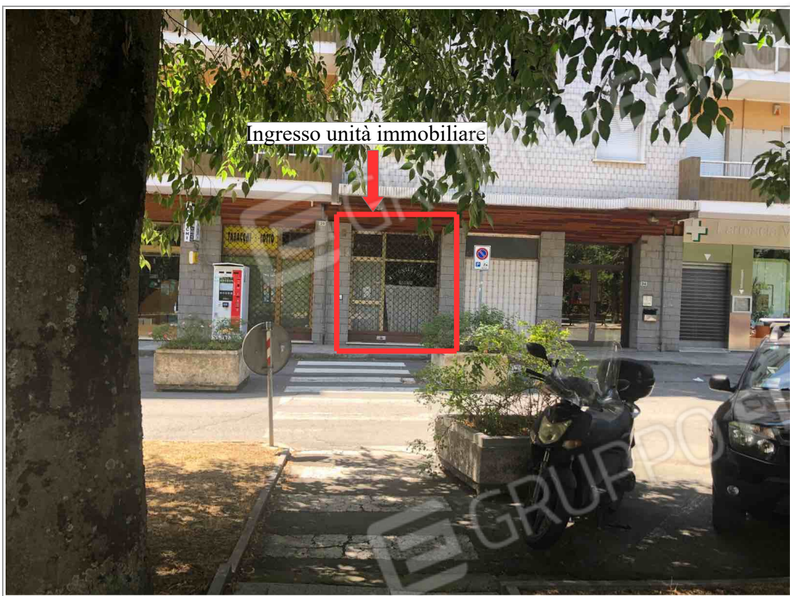
Foto n.3: ingresso fronte strada
