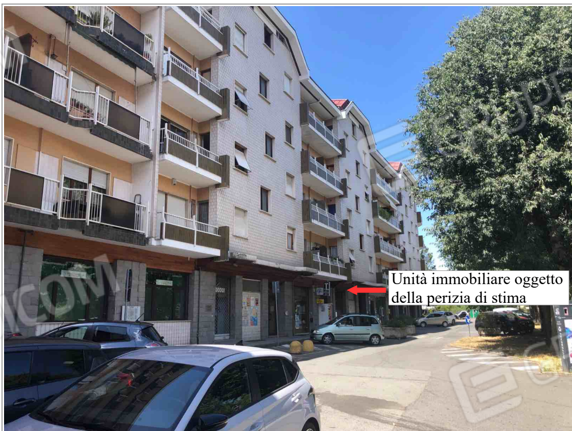
Foto n.2: strada di accesso
