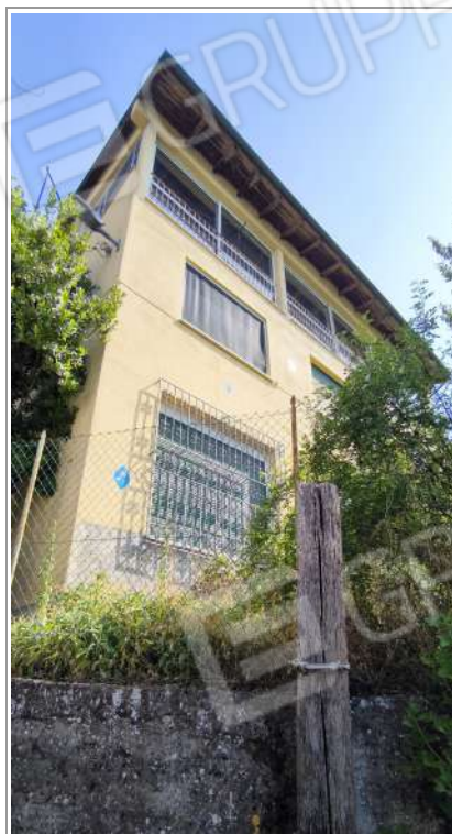
Foto n.3: facciata su lato sud
