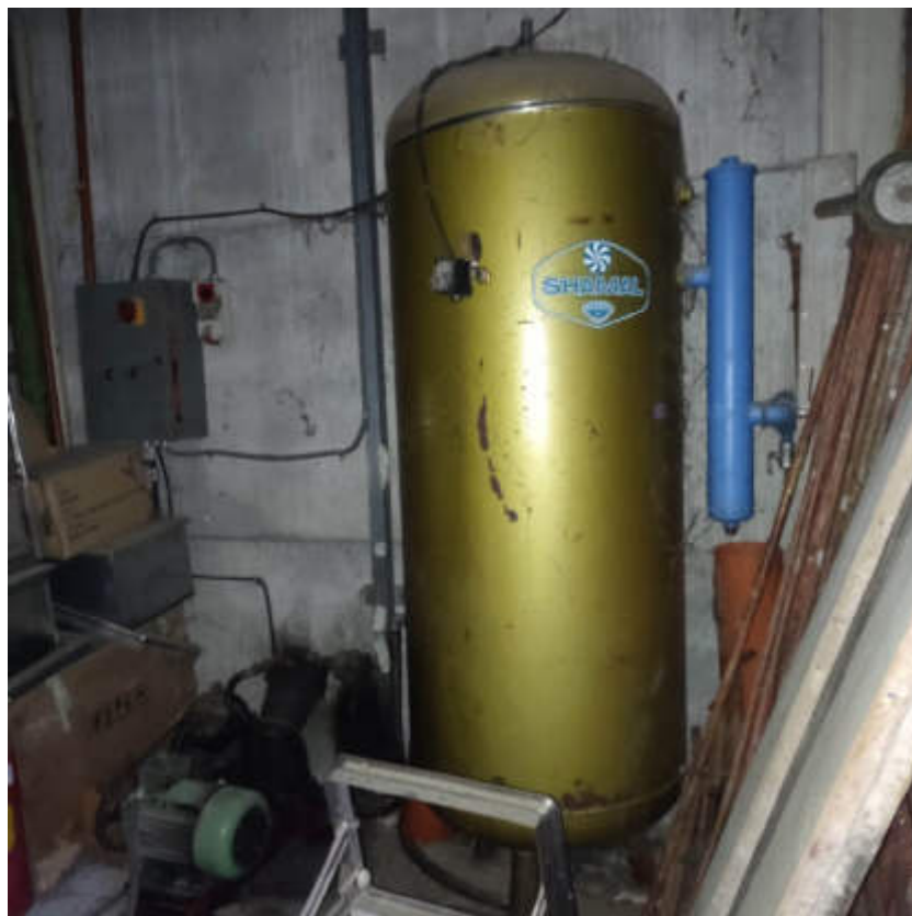
Vista interna dell'impianto di distribuzione aria compressa
