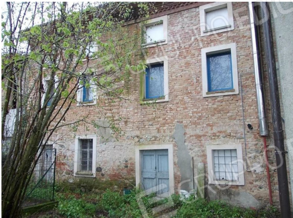
Foto 5 Prospetto nord fabbricato mapp.336 sub.2 abitazione
