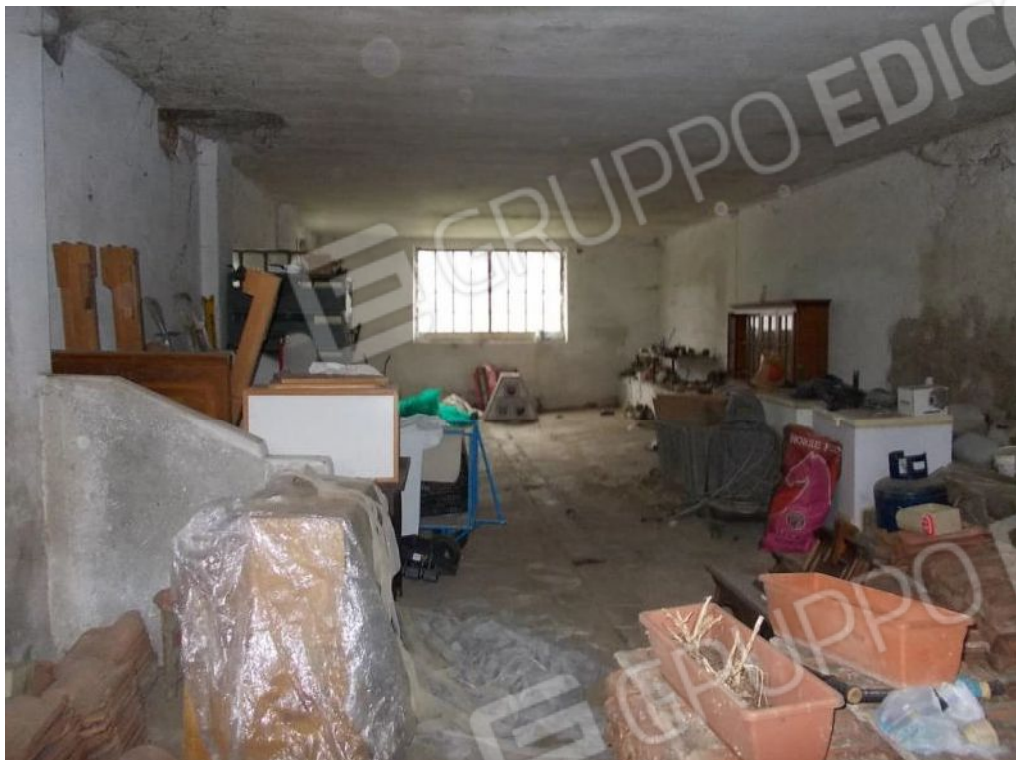
Foto 33 Locale sgombero (ex stalla) mapp.336 sub.2 p.t.
