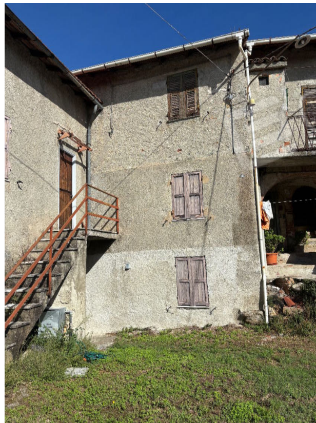
Figura A.4: sulla sinistra scala e ingresso P1 (mapp. 202); di fronte le finestre del P.T (mapp. 186) e P1. (mapp 205).
