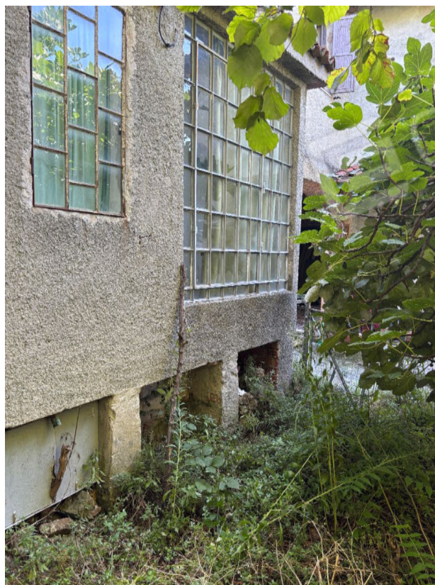
Figura A.12: P.T. (mappale 186), vista esterna corpo bagno e antibagno con relativi serramenti
