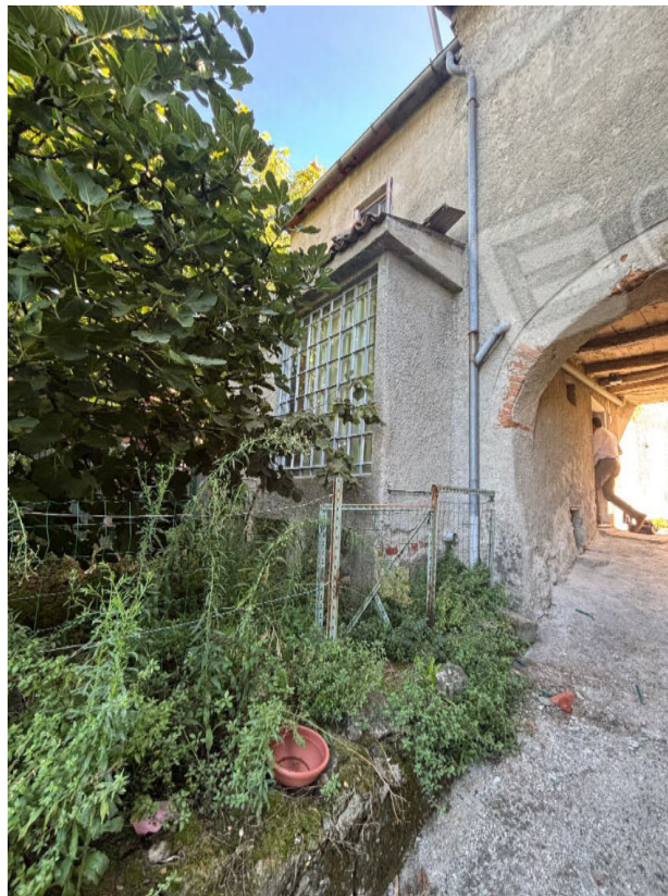
Figura A.6: accesso al giardino (che porta anche alla cantina), in primo piano la finestra del disimpegno sul bagno (corpo giustapposto).
