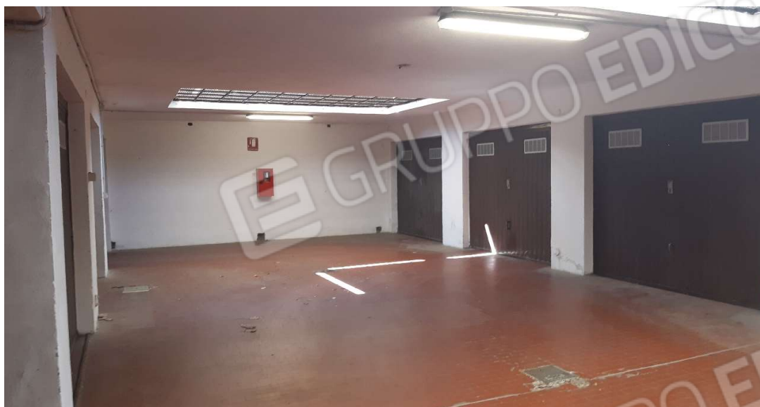
Area comune piano interrato - ultima basculante sulla destra
