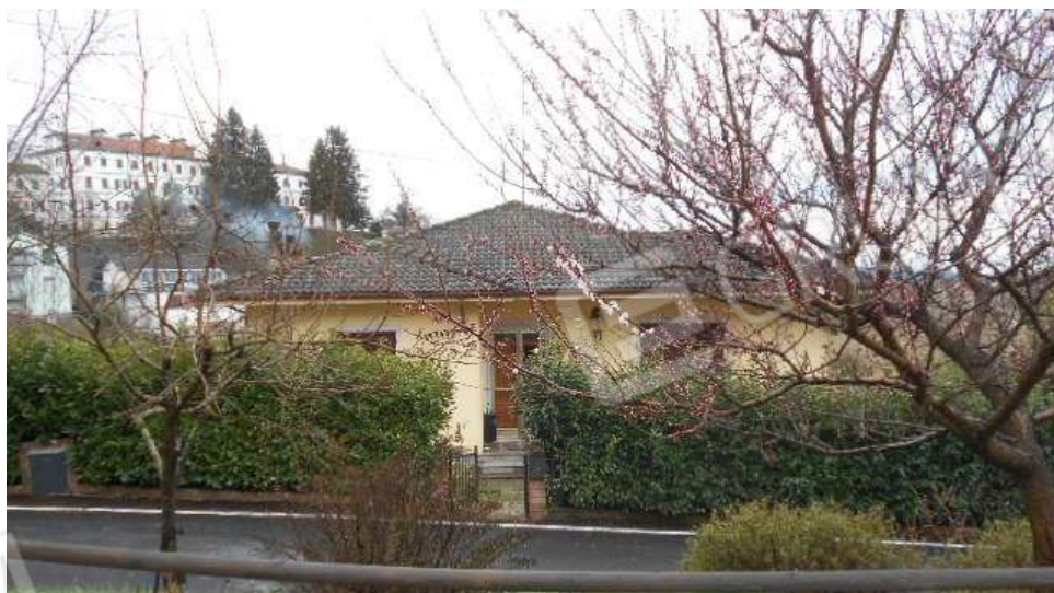
il fronte nord-est di igresso rivolto a monte e alla provinciale
