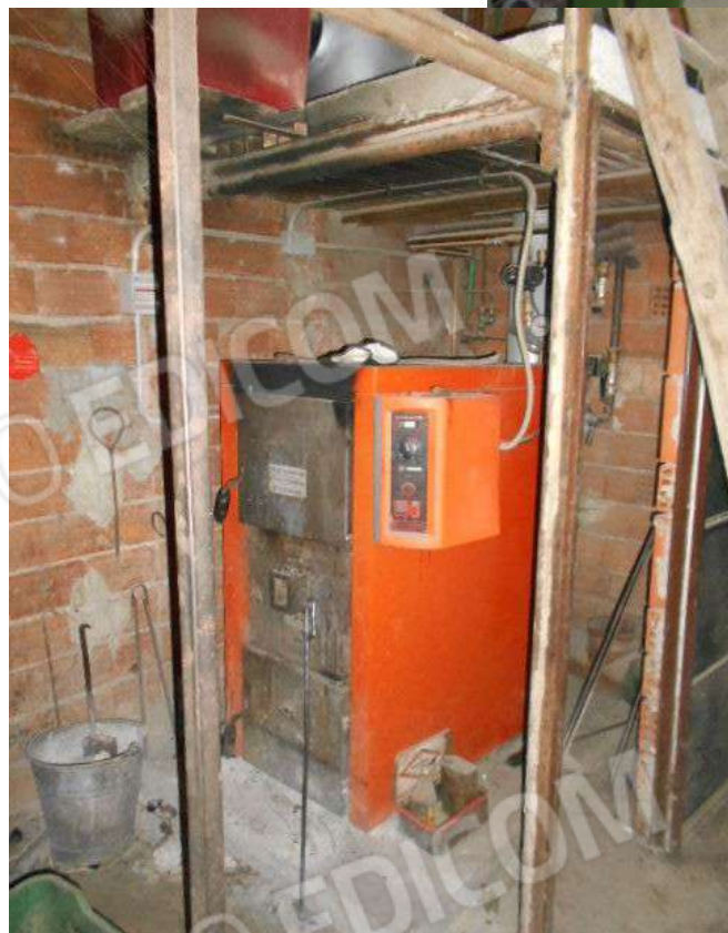
il generatore dell'impianto di riscaldamento alimentato a legna
