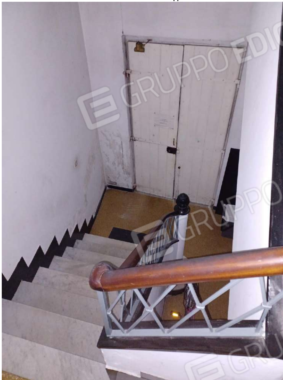
Vista interna del corpo scale
