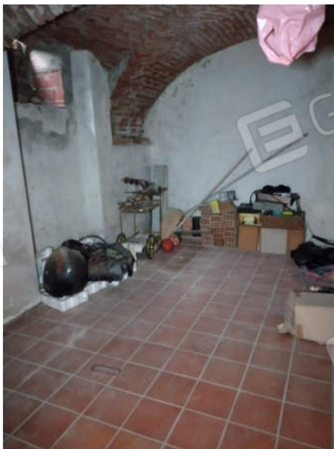
Vista interna locale cantina quota piano interrato
