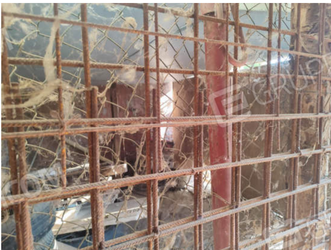
Vista esterna locale sgombero quota piano cortile
