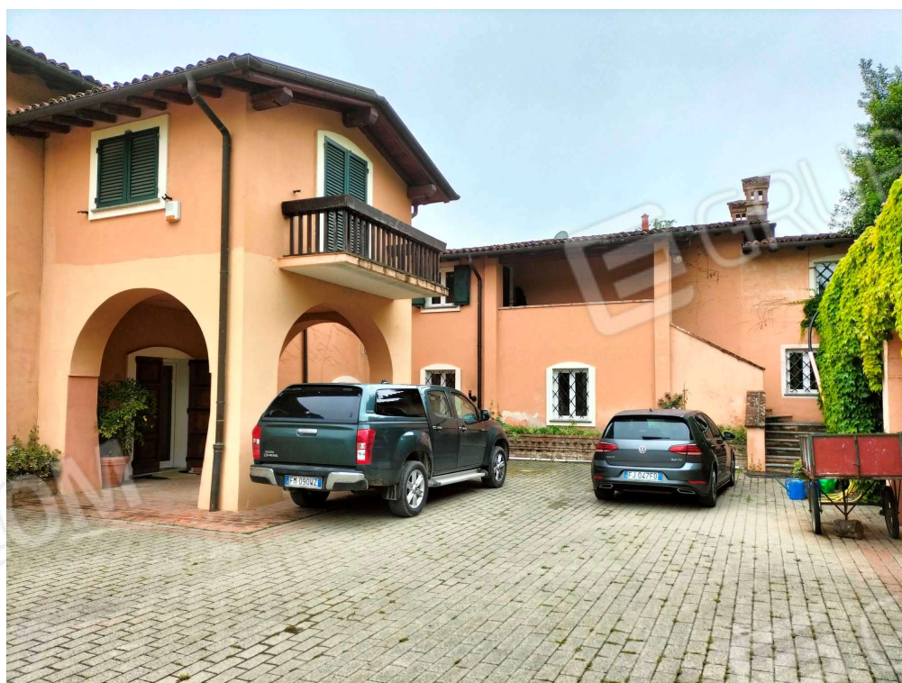
Vista arrivando da accesso principale
