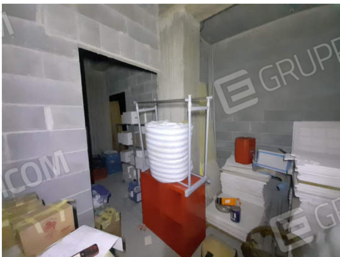
Vista interna tipologia rifiniture e suddivisione ambienti
