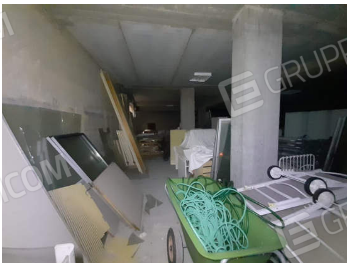
Vista interna tipologia rifiniture e suddivisione ambienti
