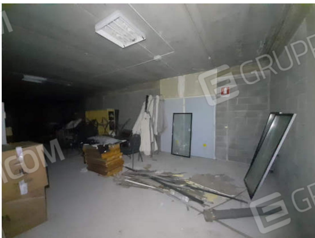
Vista interna tipologia rifiniture e suddivisione ambienti
