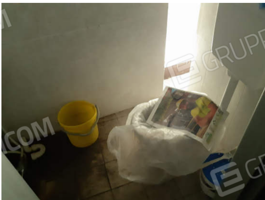
Vista interna locale bagno piano terra
