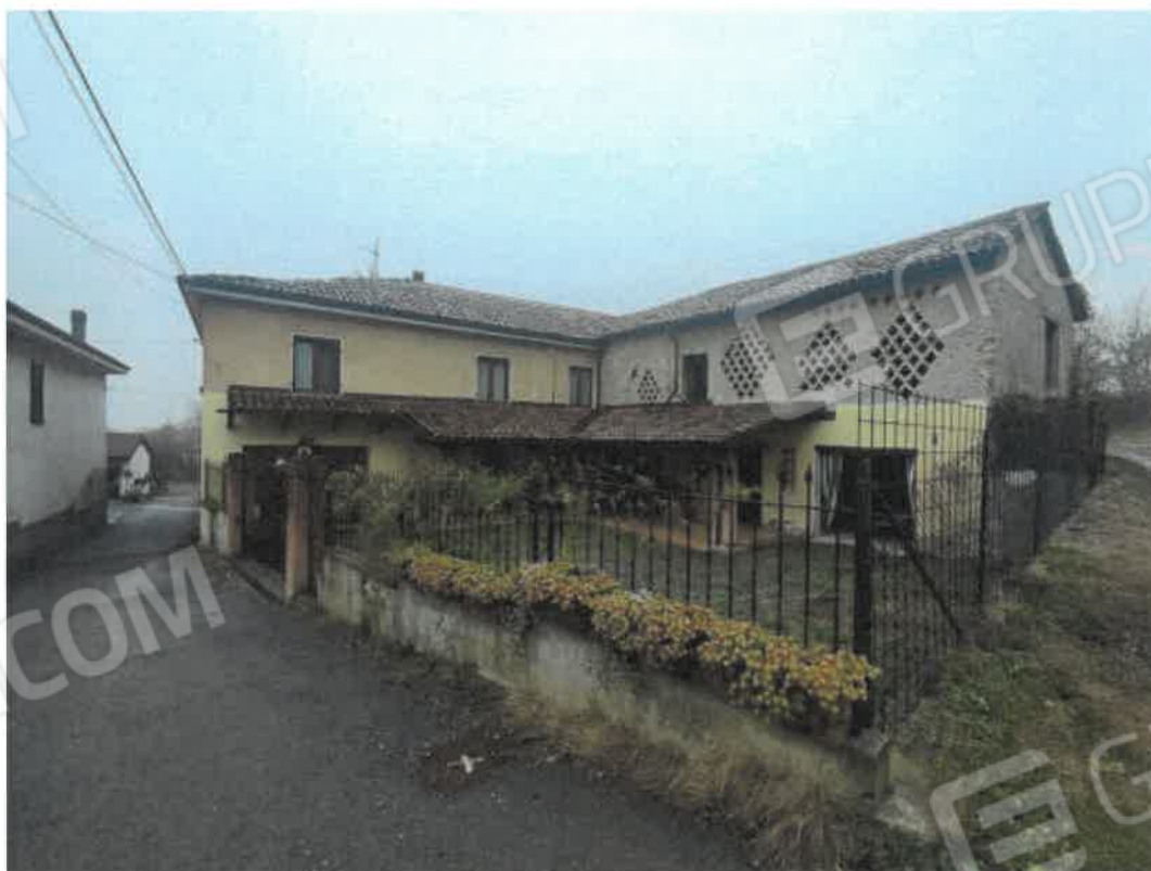
Vista prospetto fronte Sud del fabbricato
