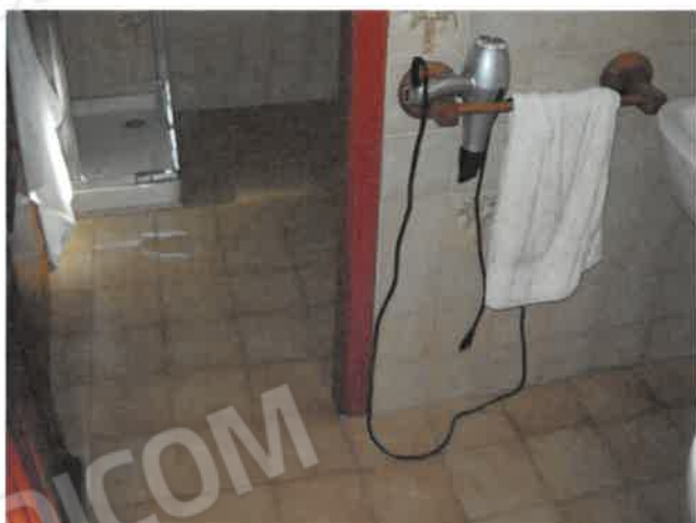
Bagno alloggio piano primo Lotto 1
