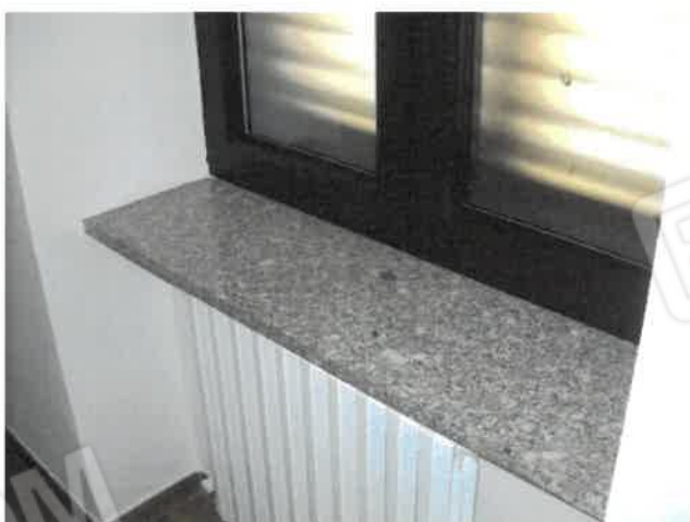
Serramenti alloggio piano primo (sub 4) Lotto 1
