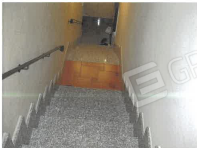
Scala ingresso alloggio piano primo 856 sub.3 - Lotto 1
