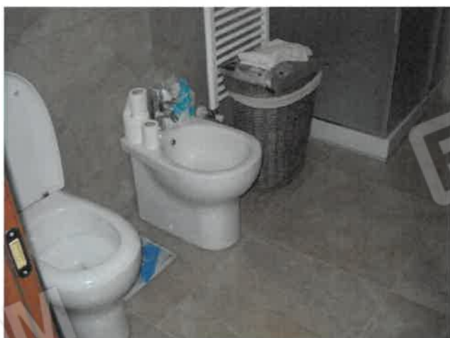
Bagno alloggio piano terra Lotto 1
