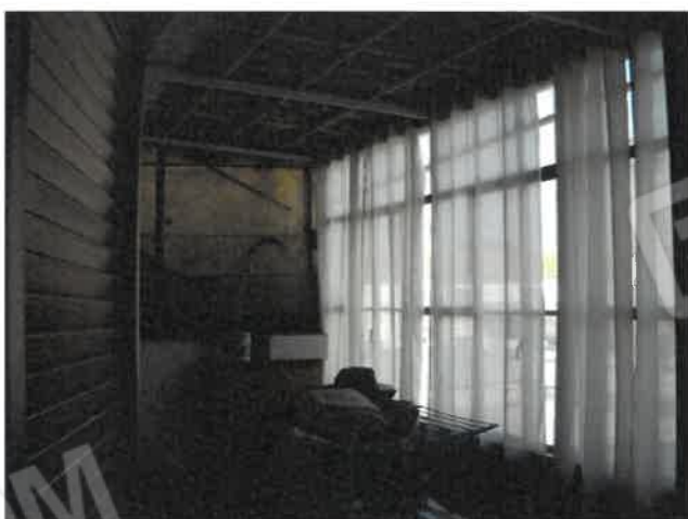
Terrazzo con veranda alloggio piano primo Lotto 1
