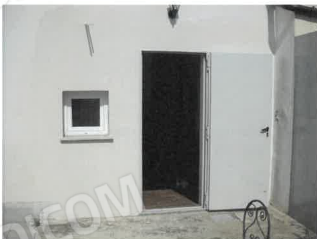
Vano ufficio non autorizzato piano terreno Lotto 1
