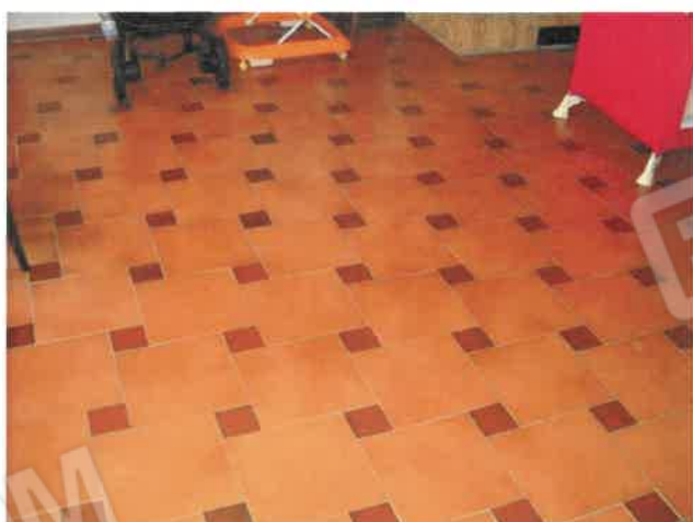
Pavimentazione alloggio piano primo Lotto 1
