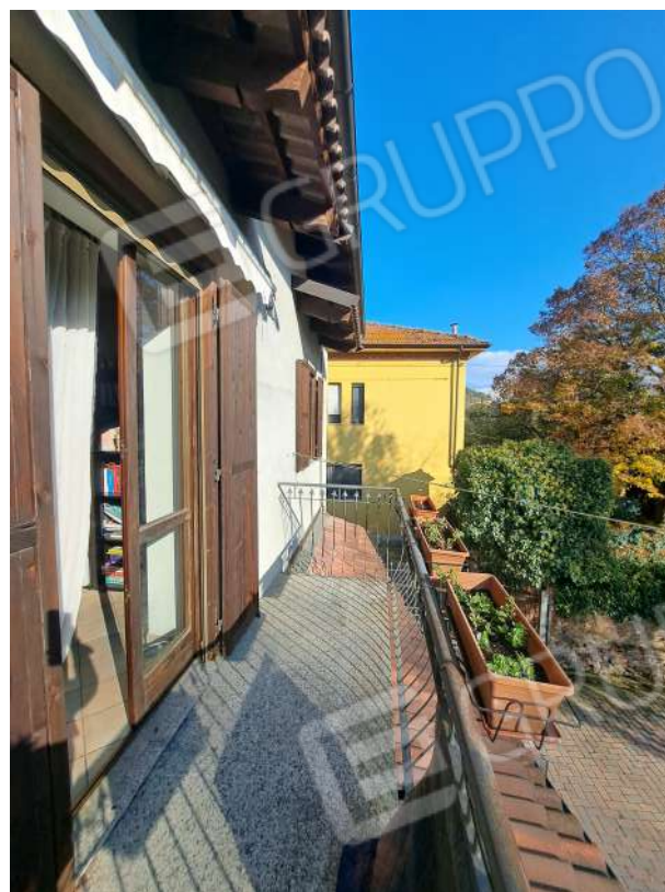
Figura 24- serramenti al piano primo e balcone
