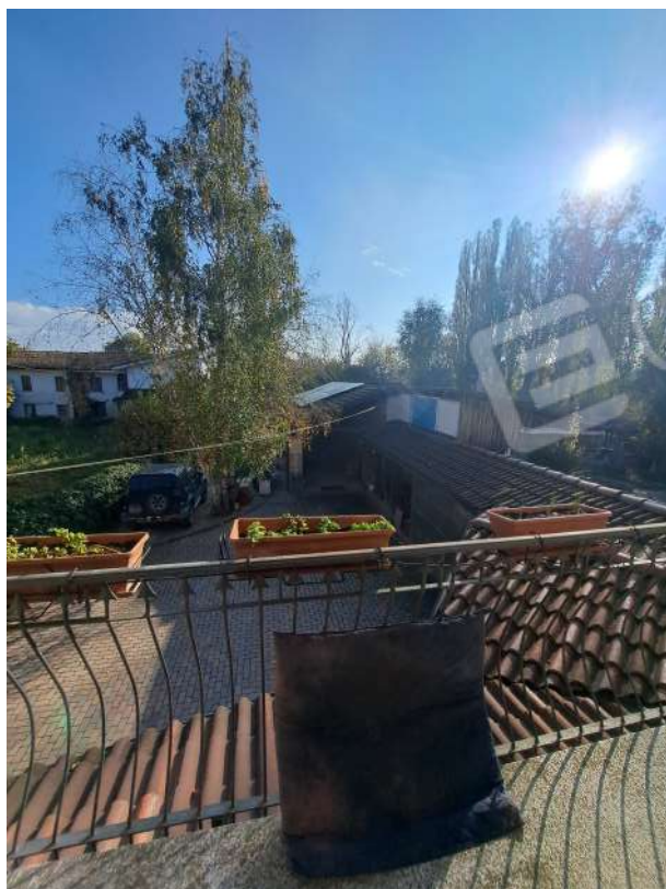
Figura 25- vista delle tettoie e delle pertinenze
