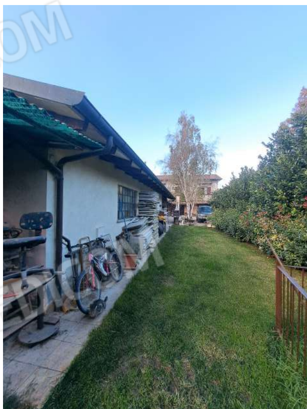
Figura 27- vista del locale di sgombero
