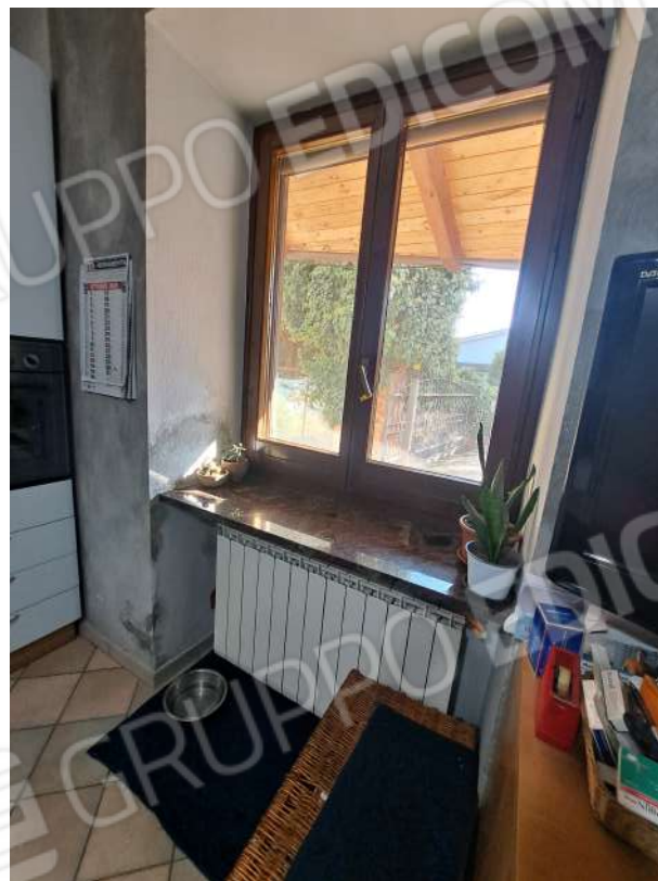
Figura 22- serramenti al piano terra
