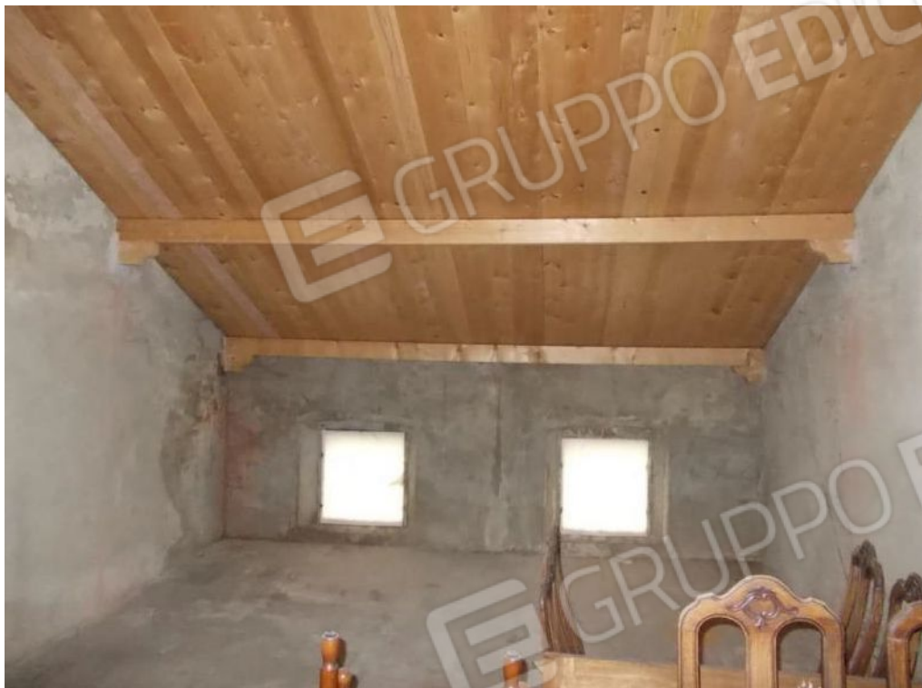
Foto 31 Locale sottotetto abitazione mapp.336 sub.2 p.1
