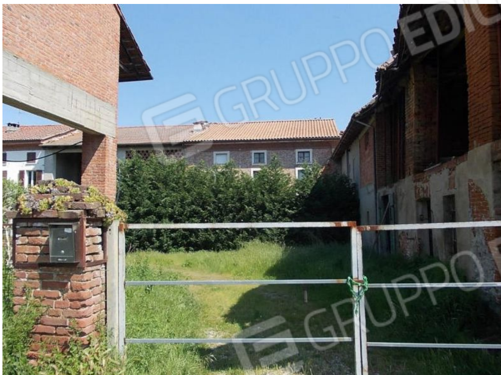
Foto 1 Ingresso fabbricati Cascina Moschina civ.18
