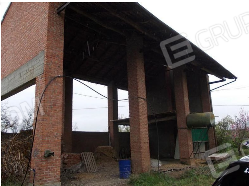
Foto 12 Prospetto nord/est mapp.336 sub.4 tettoia (ex rurale)
