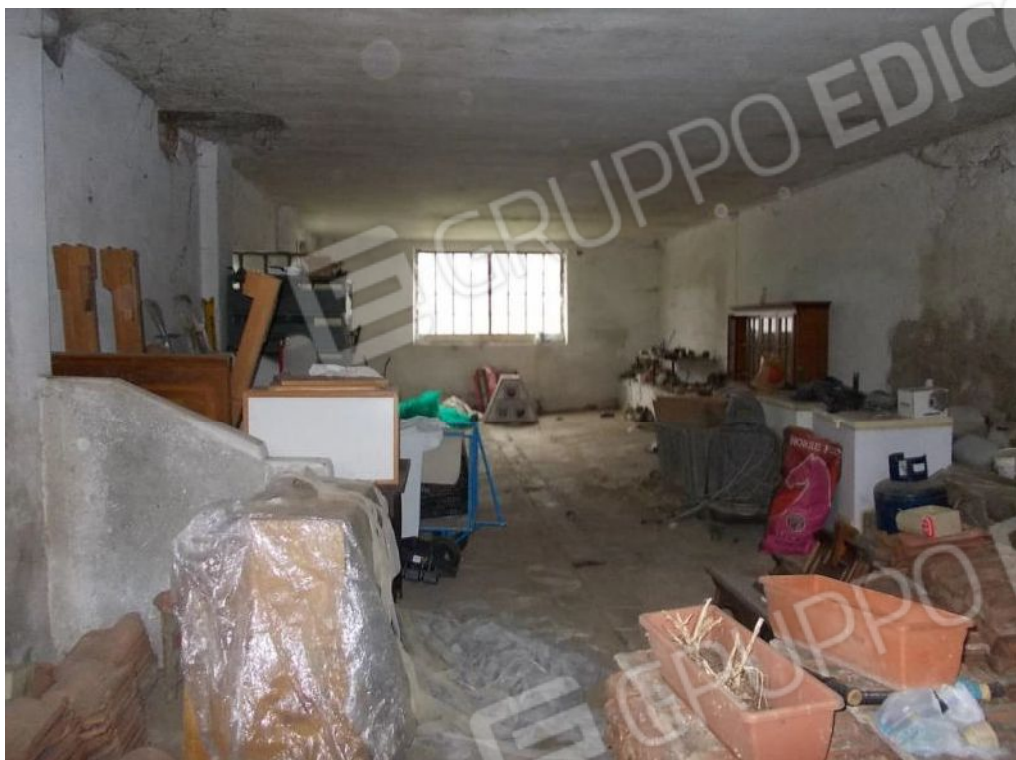
Foto 33 Locale sgombero (ex stalla) mapp.336 sub.2 p.t.
