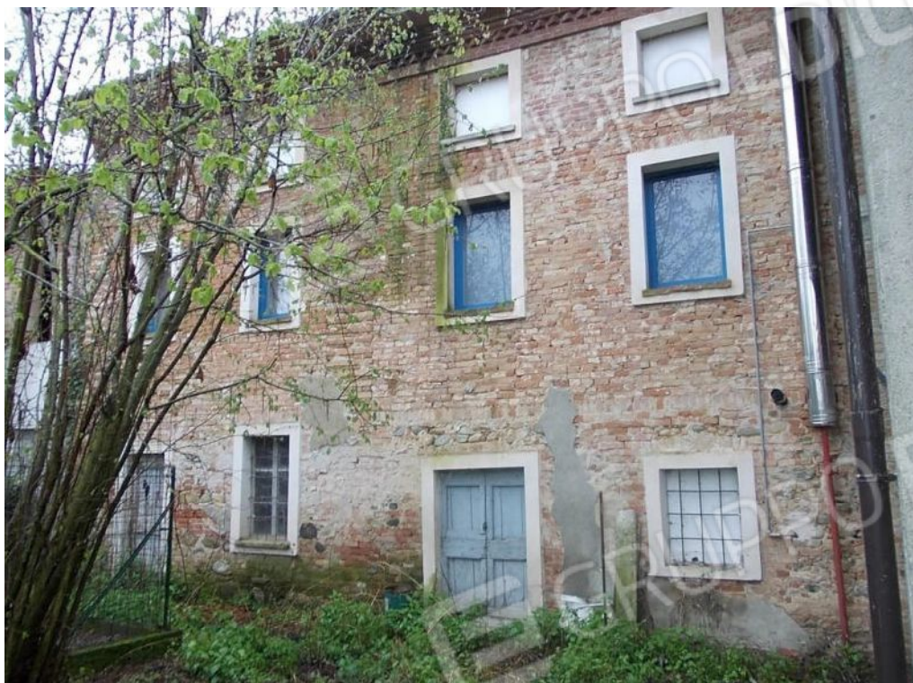
Foto 5 Prospetto nord fabbricato mapp.336 sub.2 abitazione
