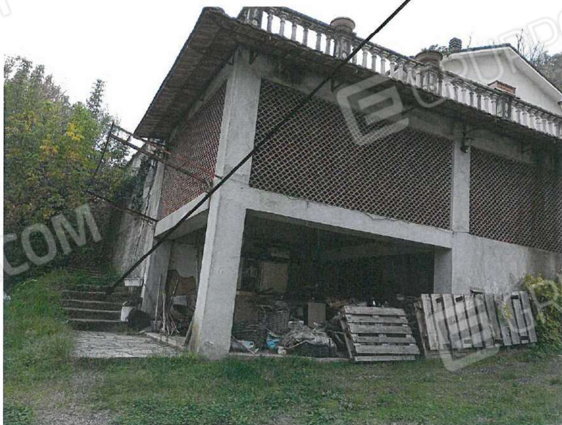
Foto n. 6_ MAGAZZINO CON SOVRASTANTE TERRAZZO, SCALA DI ACCESSO AL FABBRICATO ABITATIVO
