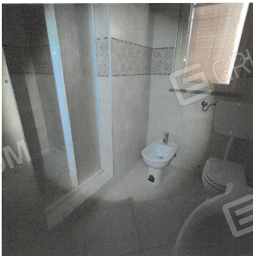
Vista interna locale bagno in piano primo
