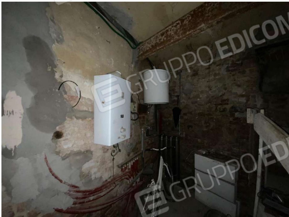
LOCALE CENTRALE AL PIANO SEMINTERRATO
