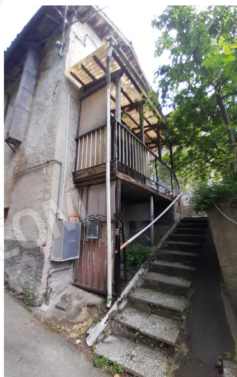
Accesso all'unità abitativa
