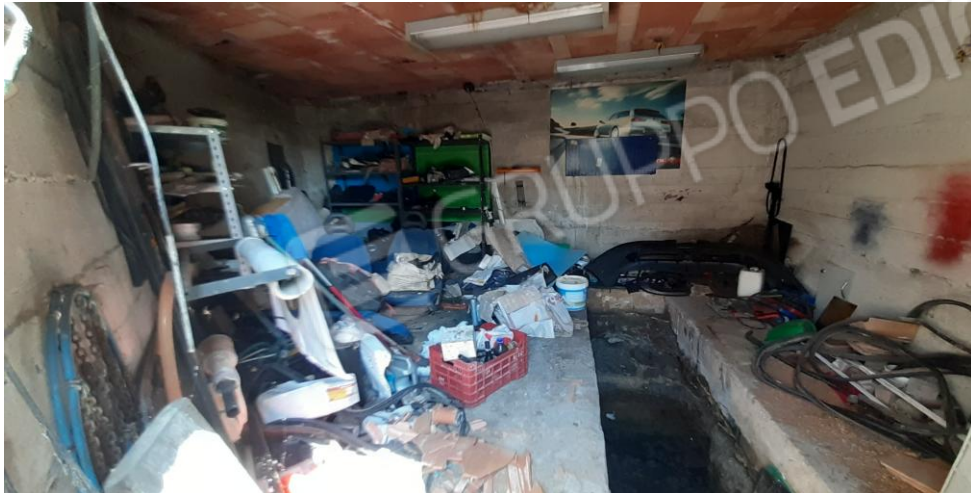
Vista interna - Autorimessa
