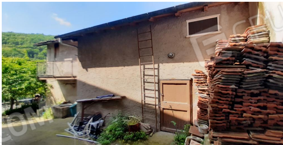
Vista esterna - Lato Corte
