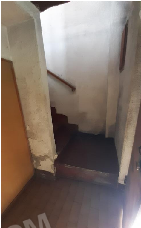
Vista interna - Vano Scala
