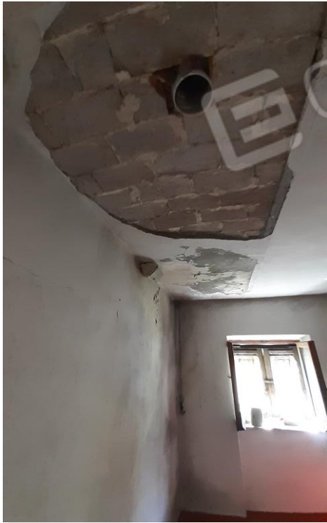
Vista interna - dettaglio soffitto
