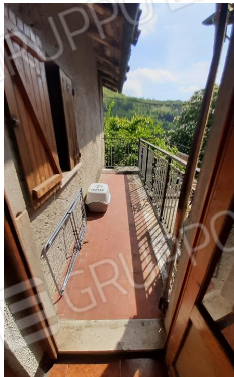
Vista esterna - Terrazzo
