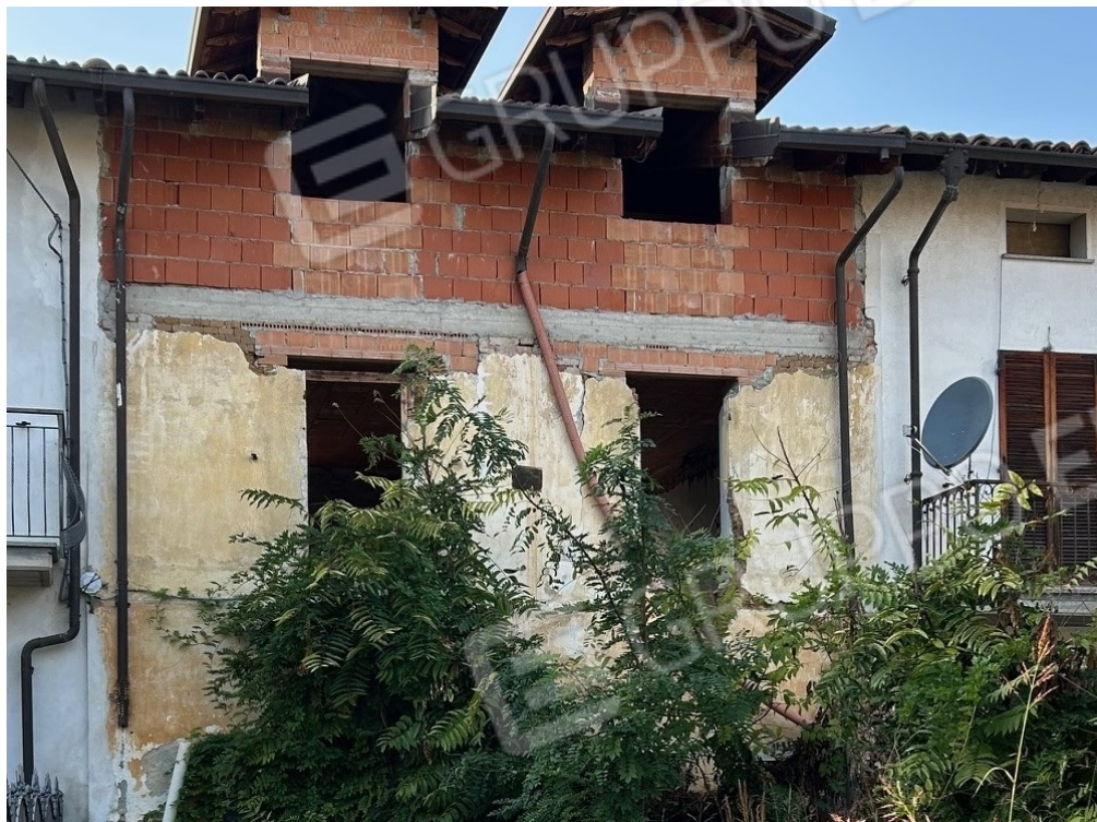
FOTO 1 – Prospetto attuale Fabbricato
