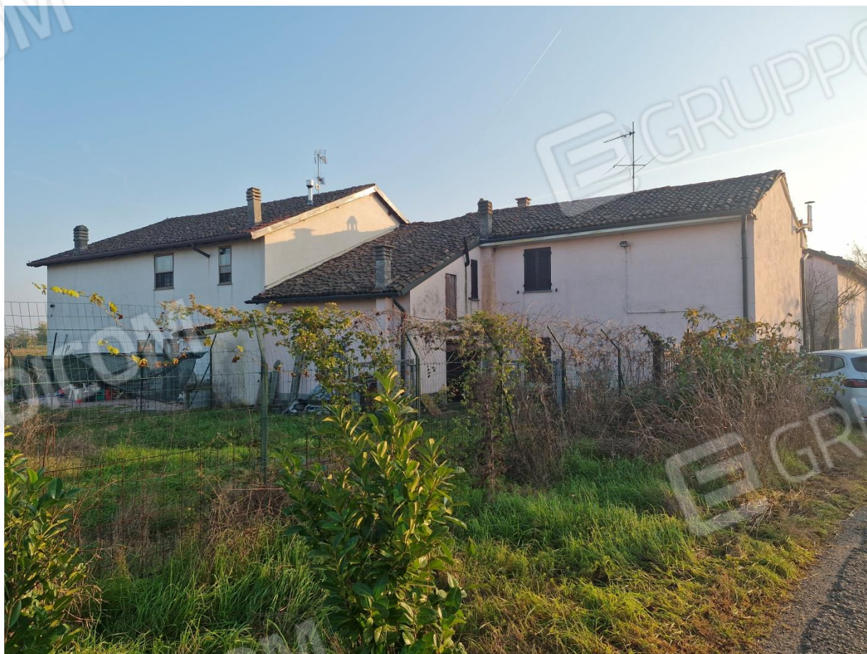
FOTO 2 – Vista esterna lato Nord – CORPO A+B
