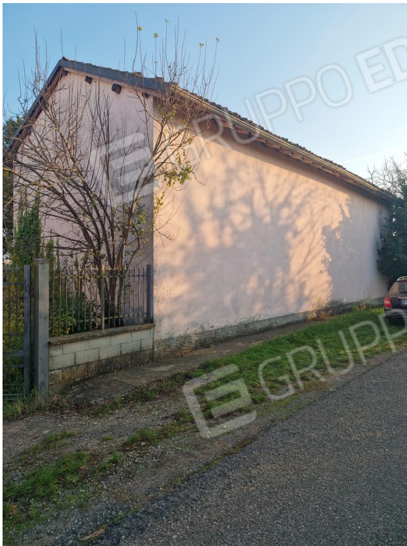
FOTO 3 – Vista lato strada locali pertinenziali - CORPO A
