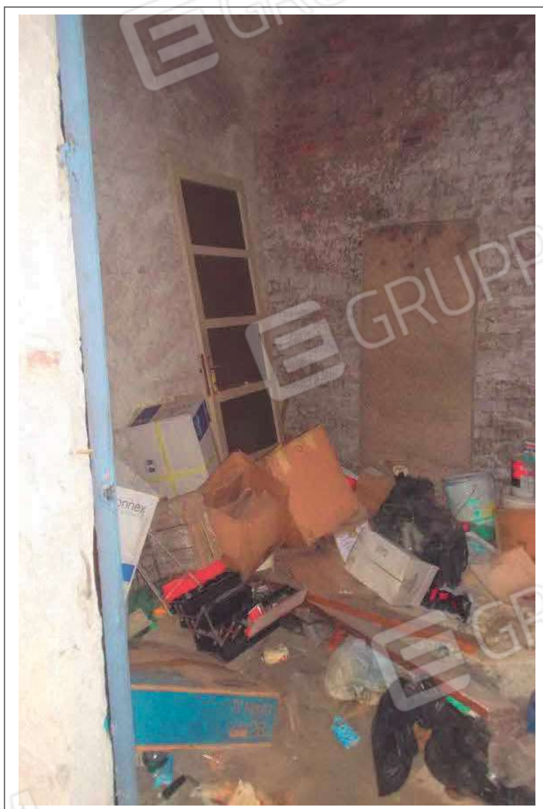
Fotografia n. 12 = Vista interna della cantina
