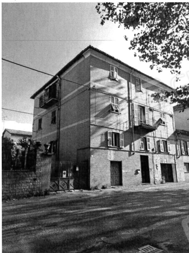
Figura 1- Facciata verso via P.Isola
