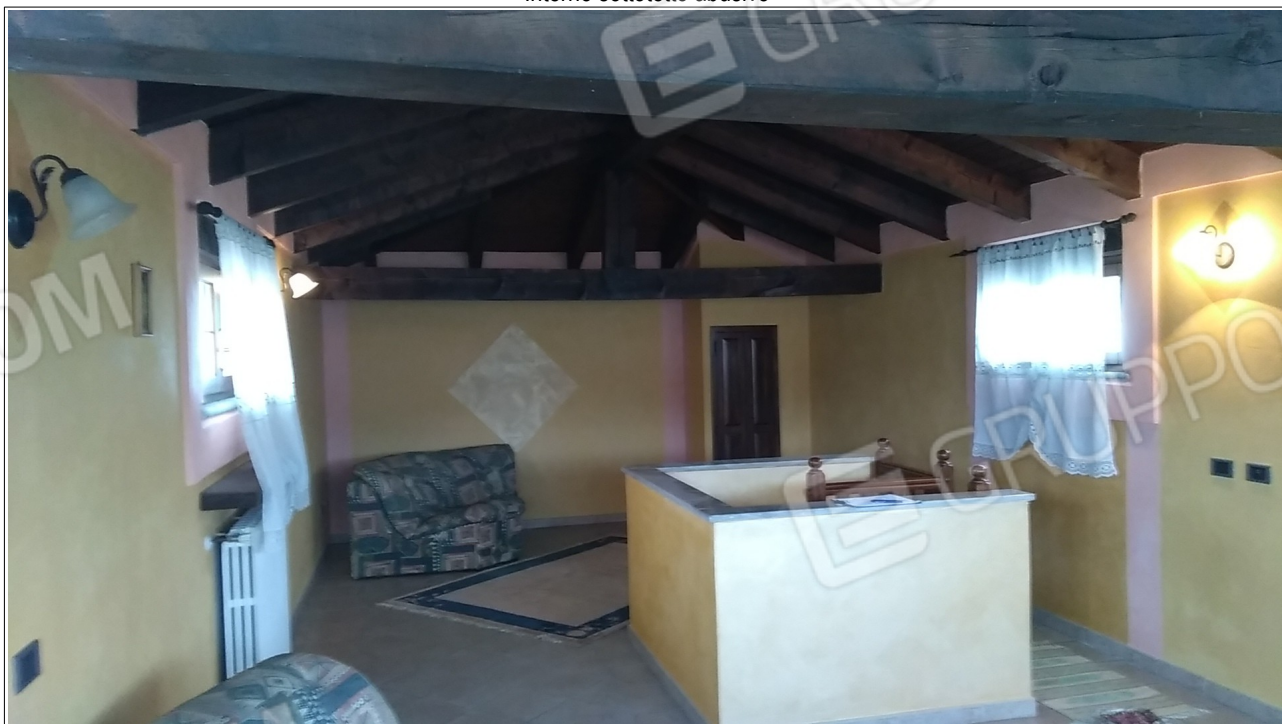
Interno sottotetto abusivo
