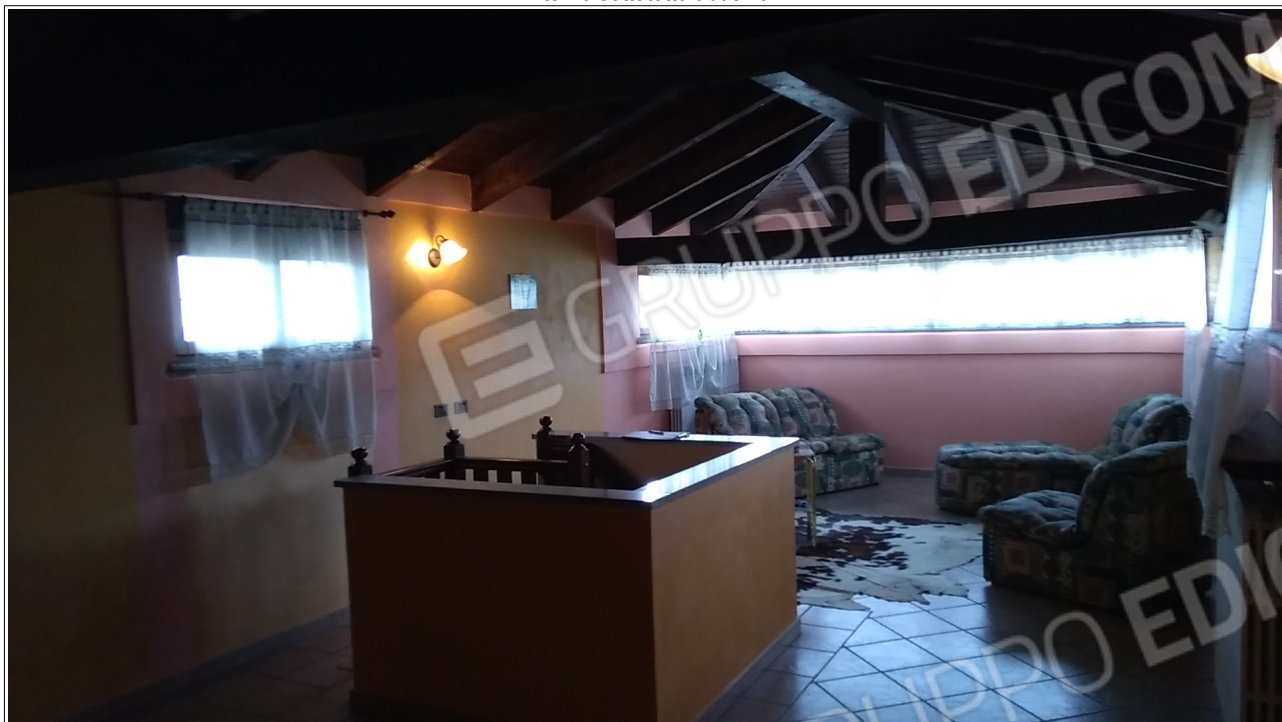
Interno sottotetto abusivo
