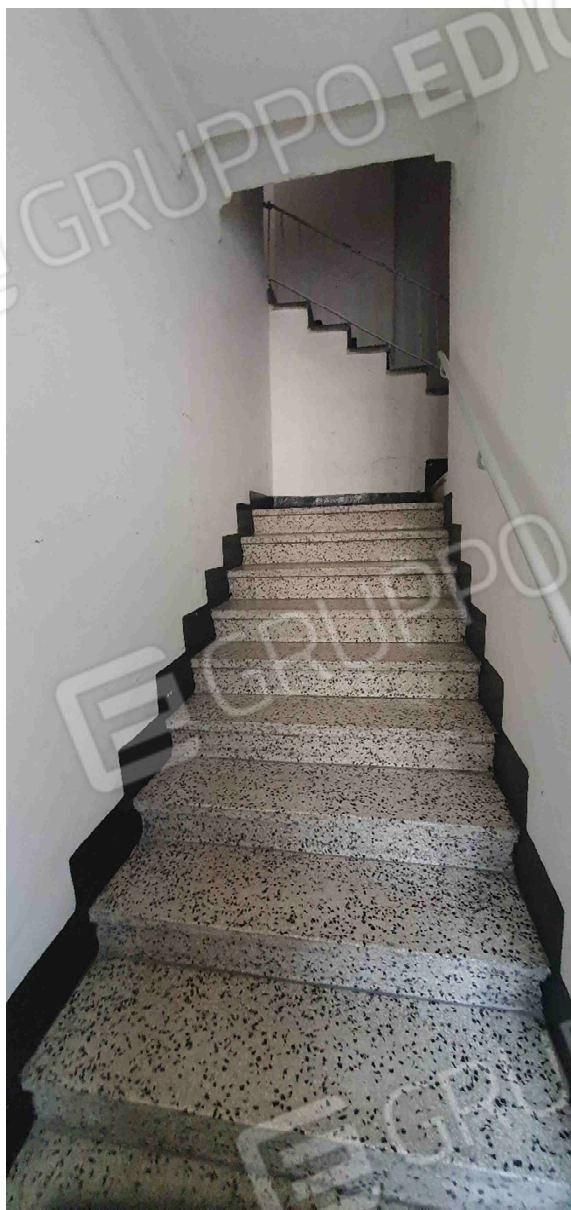
VANO SCALA CONDOMINIALE
