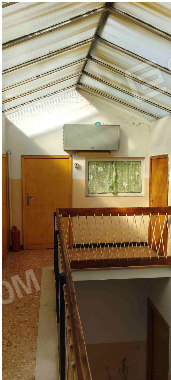
Locale Ripostiglio Sottotetto
