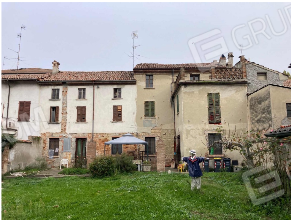
Foto 2 – Prospetto abitazione dal cortile
