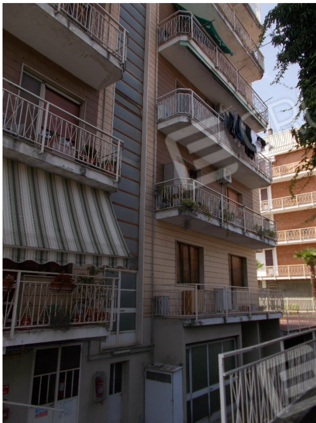
Foto 3. Accesso al piano seminterrato dal cortile interno
