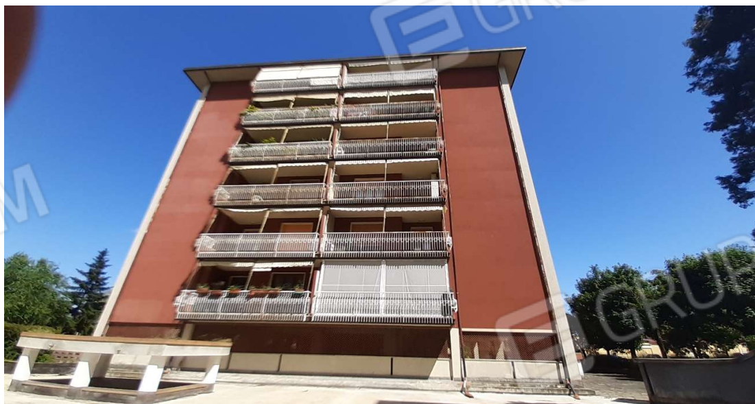
Fronte ovest - Piano quinto terrazzo a destra
