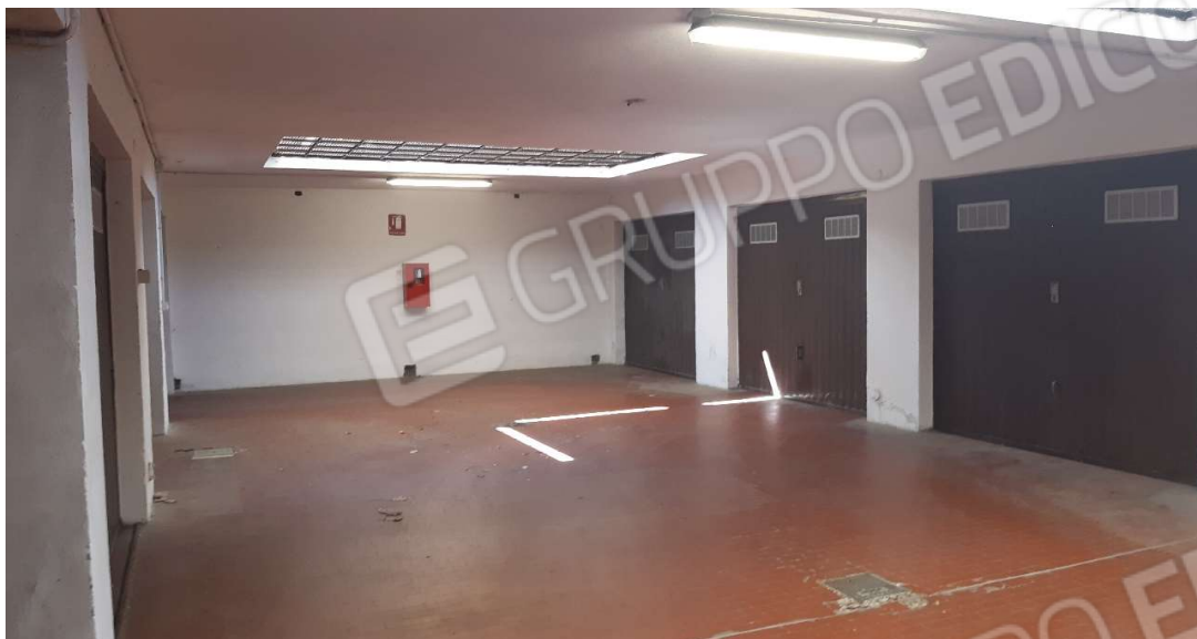
Area comune piano interrato - ultima basculante sulla destra
