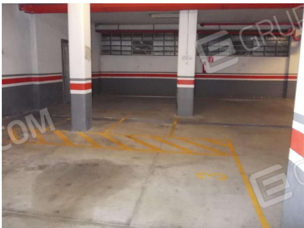
Foto 4 Interno Autorimessa mapp.5404 sub.51 p.S1
