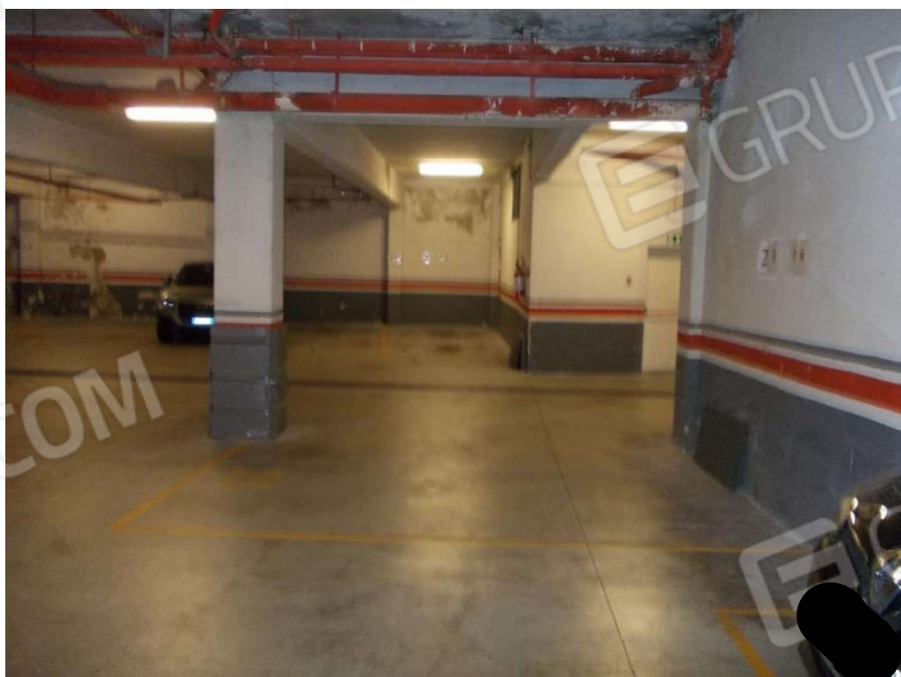
Foto 8 Interno Autorimessa mapp.5404 sub.51 p.S1
