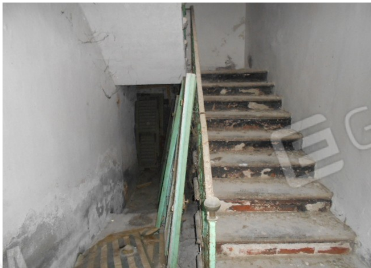
ingresso e vano scale
