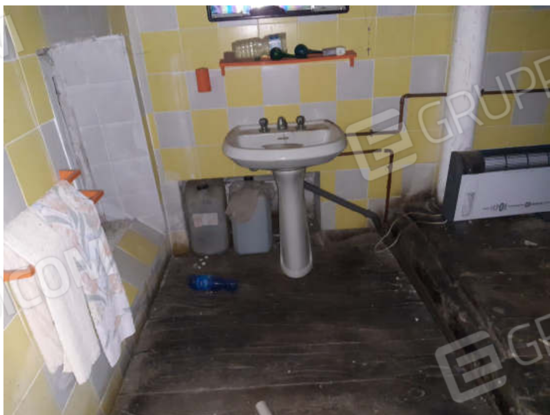
Vista interna locale bagno in piano secondo
