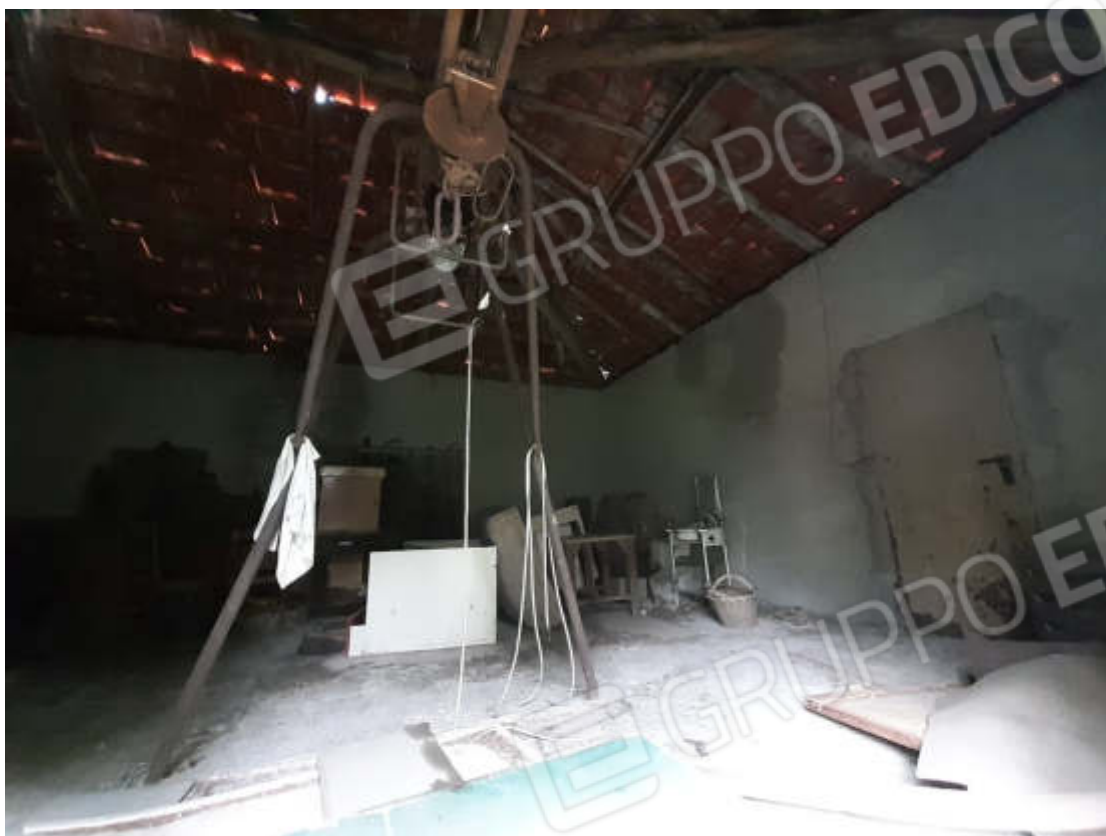
Vista interna locale fienile in piano primo
