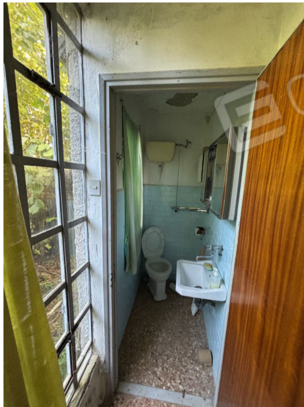
Figura A.8: P.T. (mappale 186), vista del servizio igienico
