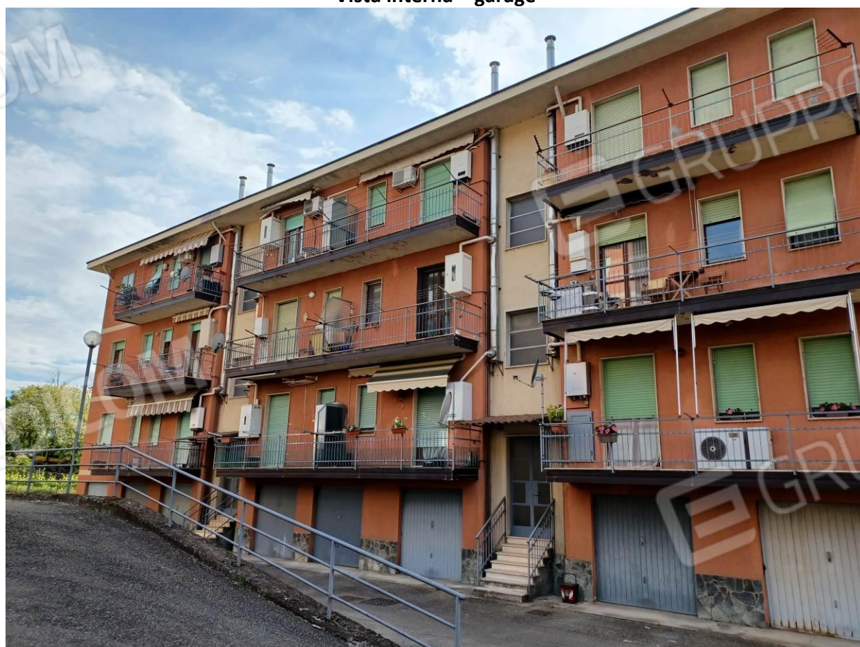
Vista generale dell'immobile – prospetto di retro
