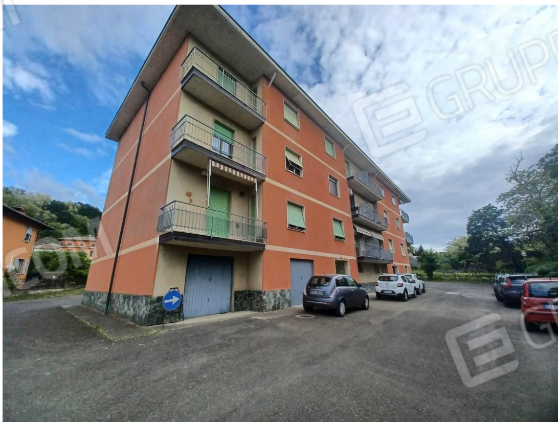
Vista generale dell'immobile – prospetto principale
