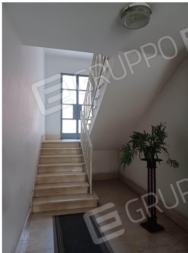
Vista interna – vano scala condominiale
