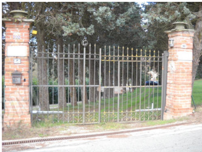
Ingresso Cascina Icardi su via del Sabbione 102
