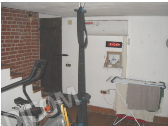
Impianto fotovoltaico mappale 488 sub.1 piano terreno
