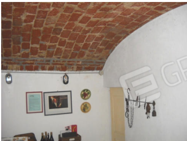
Volta in mattoni mappale 488 sub.1 piano terreno
