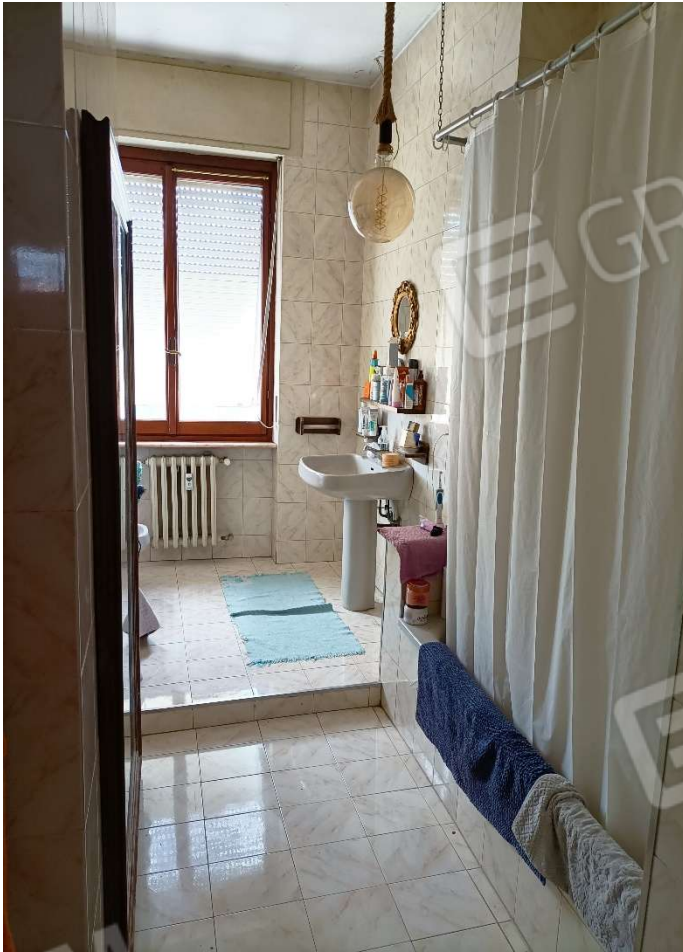
bagno con vasca foto 13-14)
