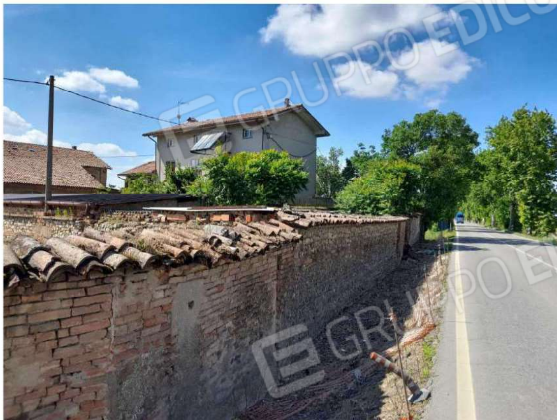
FOTO 1 - VEDUTA DALLA STRADA
