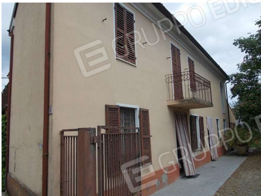
Foto 3 Prospetto sud/ovest fabbricato –ingresso pedonale/carraio
