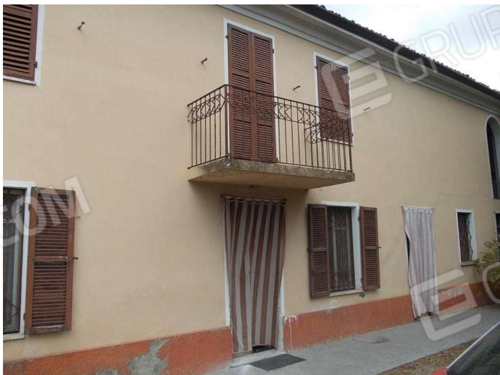
Foto 4 Prospetto sud fabbricato da cortile
