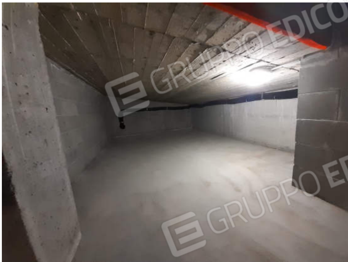
Vista interna della U.I.U. oggetto di valutazione
