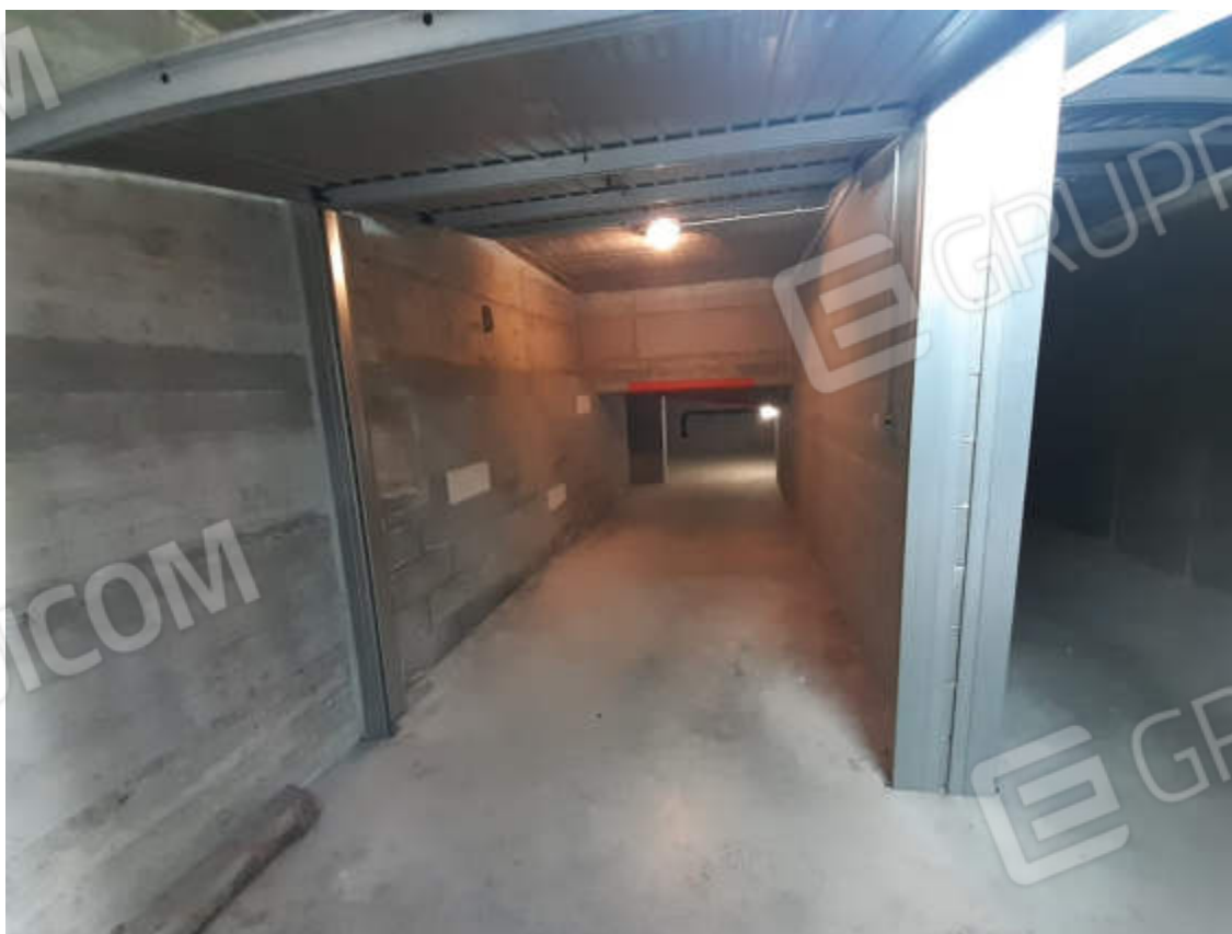
Vista interna della U.I.U. oggetto di valutazione
