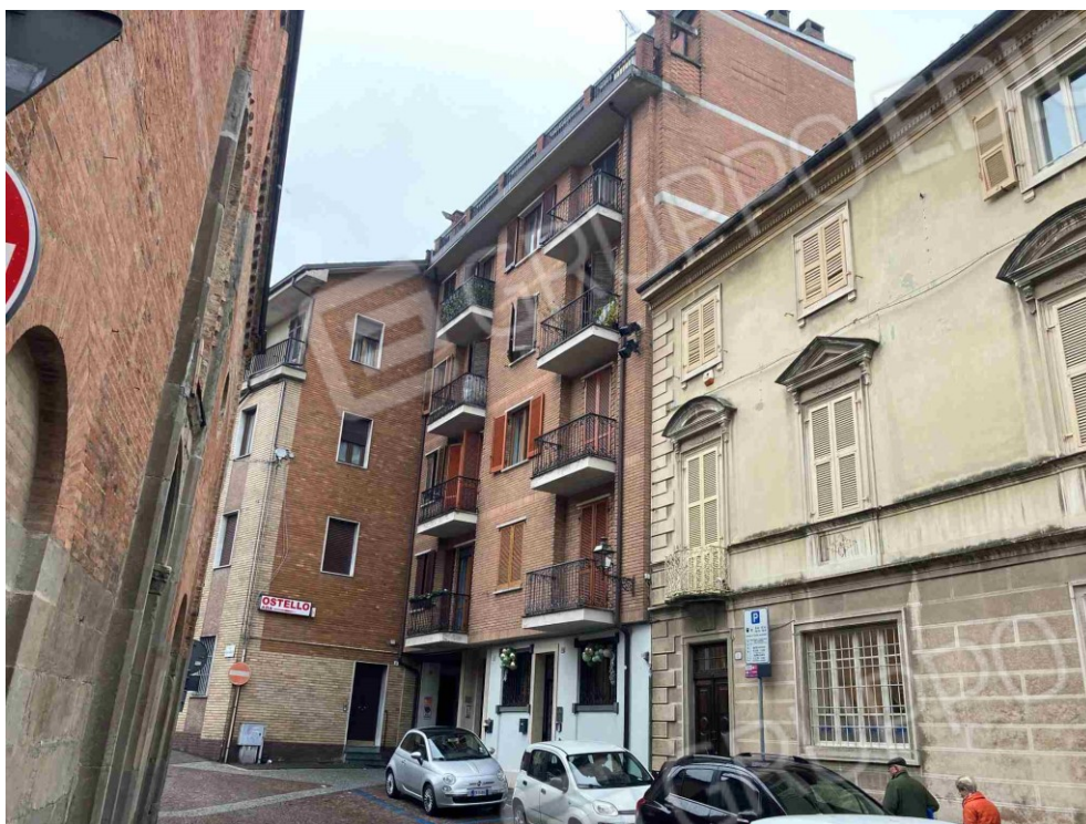
Foto 1 – Prospetto da Piazza Santa Maria Canale
