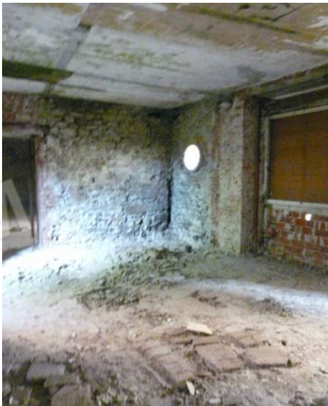
Foto 25 Interno magazzino piano primo sub 11
