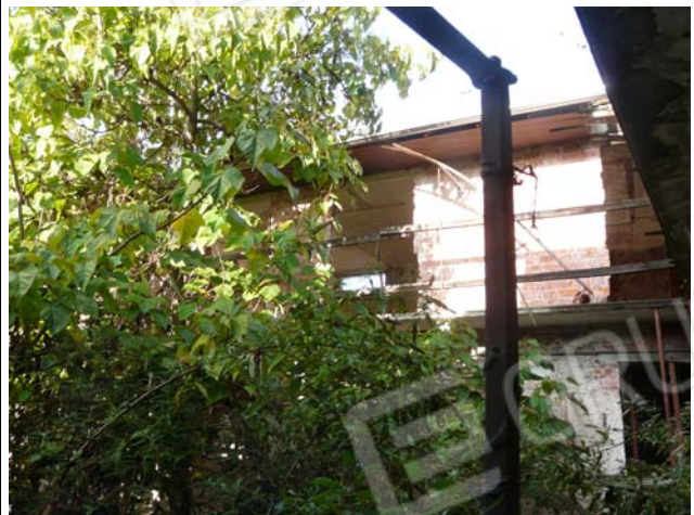
Foto 16 Facciata est sub 3 piano primo e sub 6 piano secondo
