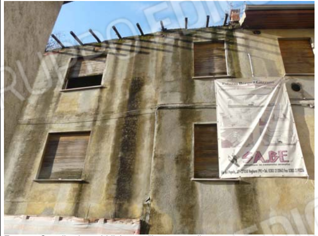
Foto n.5 Cartello che pubblicizzava l'intervento di recupero
