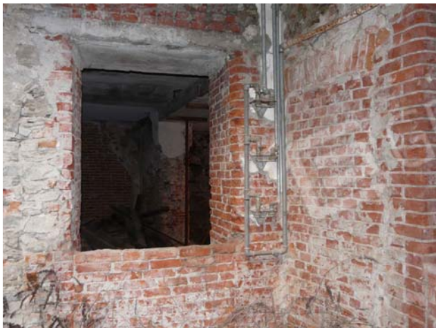
Foto 10 Facciata est sub 7 verso corte comune
