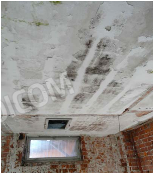
Foto 33 intradosso solaio piano secondo sub 11
