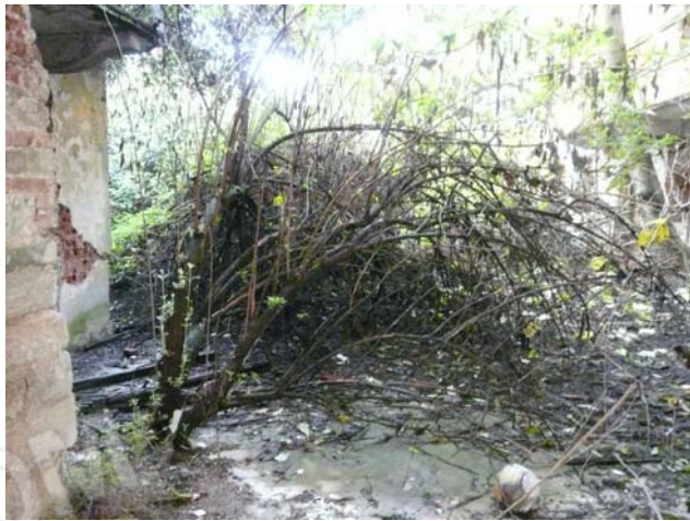
Foto 6 Corte Comune vista dall'androne carraio
