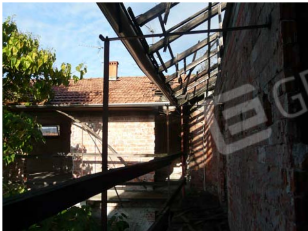
Foto 29 Facciata sud-est piano secondo
