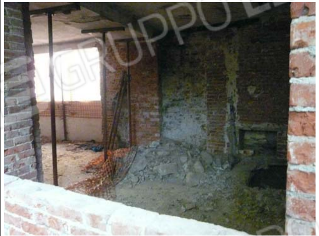
Foto 7 Interno magazzino sub. 7 piano terreno
