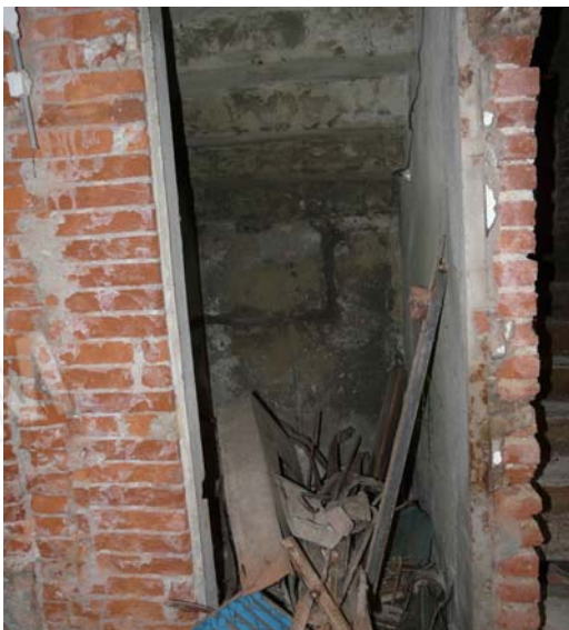
Foto 19 Sottoscala piano terreno
