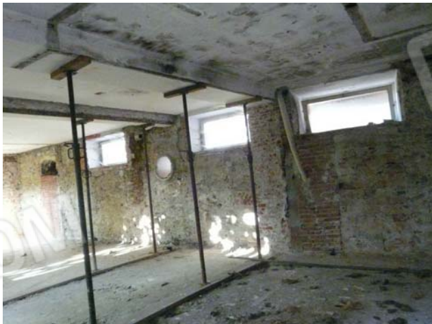
Foto 12 Interno sub 3 al piano primo orientamento ovest
