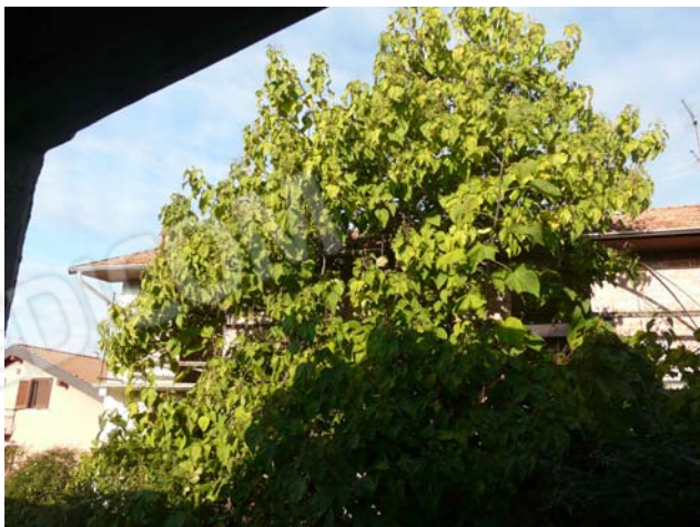
Foto 15 Facciata est sub 3 piano primo e sub 6 piano secondo
