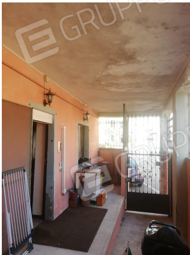
Ripresa fotografica n. 04 Particolare ingresso pedonale esclusivo
