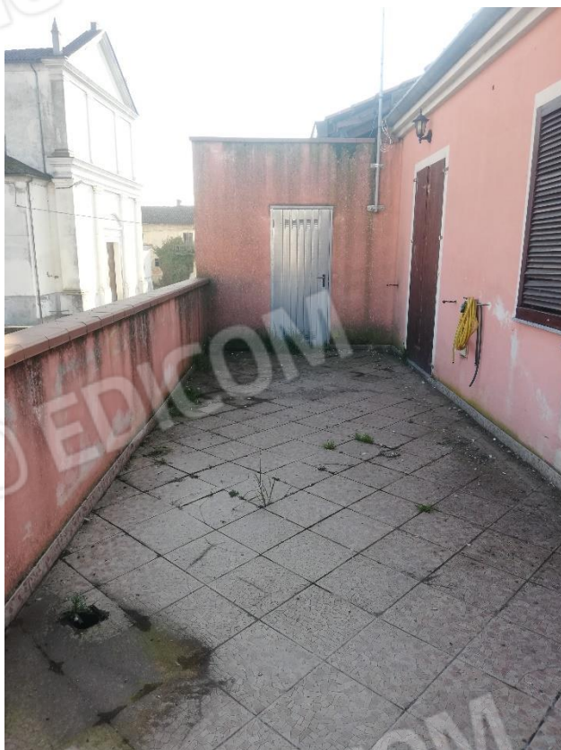
Ripresa fotografica n. 39 Particolare terrazzo scoperto P1
