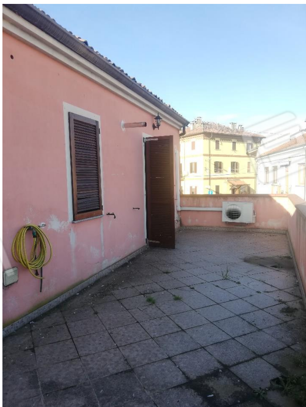
Ripresa fotografica n. 41 Particolare terrazzo scoperto P1
