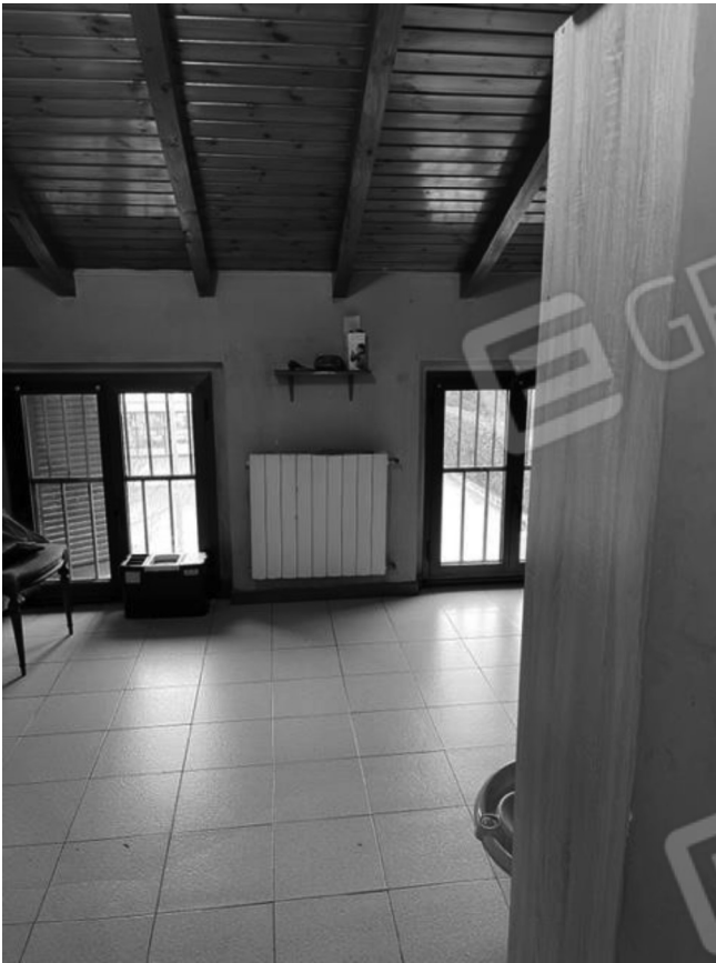
Locale sottotetto non abitabile
