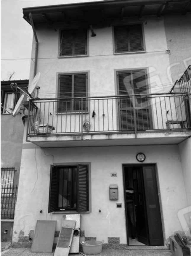
Facciata lato cortile
