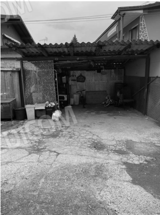
Tettoia (non autorizzata)
