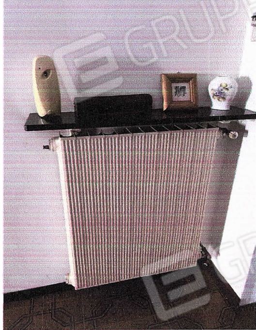
16-17. Riprese fotografiche della caldaia esterna (nicchia sul balcone lato est) e termosifone in ghisa
